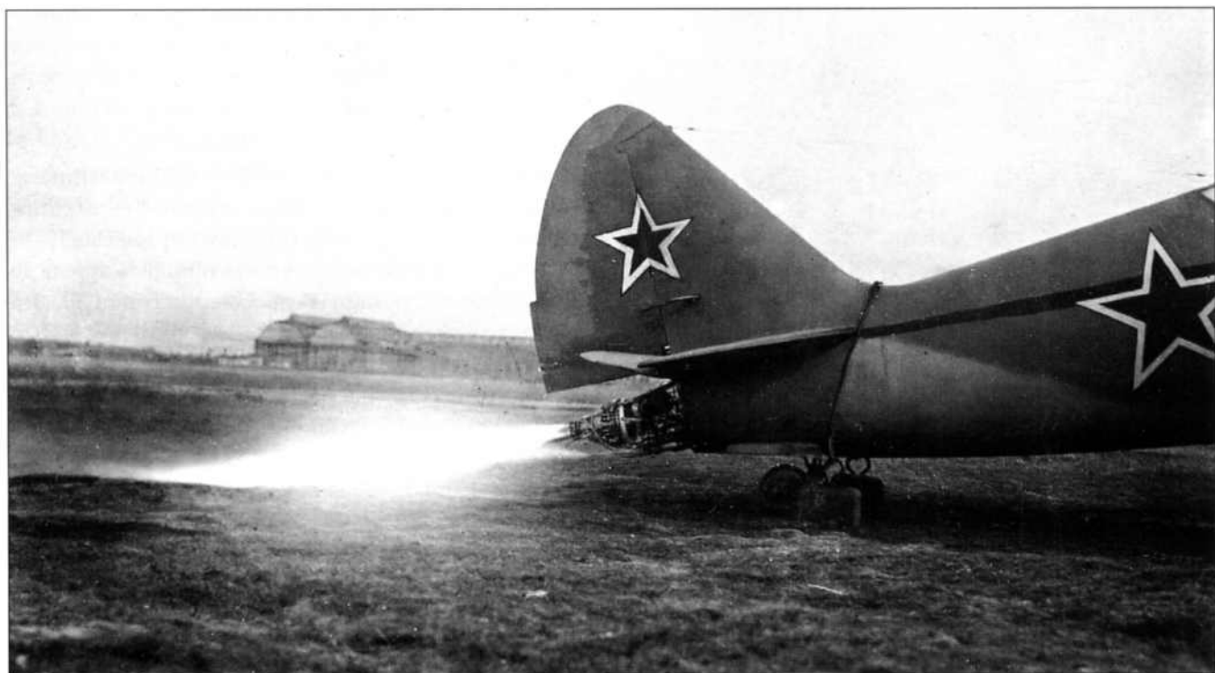
Наземные испытания ЖРД РД-1ХЗ
