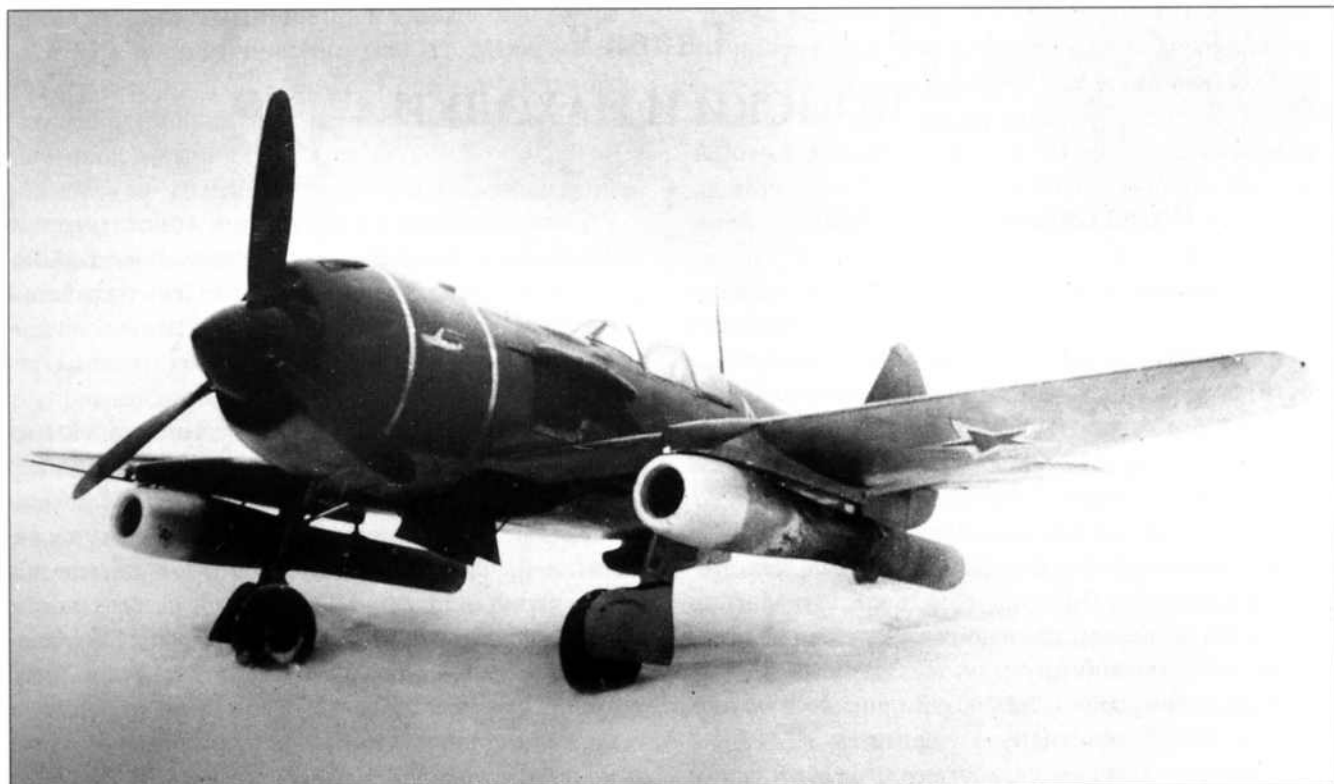
Ла-9 с ПВРД конструкции В.Н.Челомея
