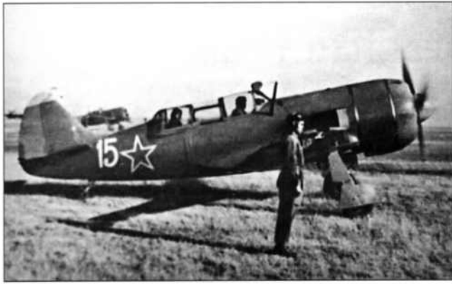
Ла-9В с силовой установкой от истребителя Ла-11
