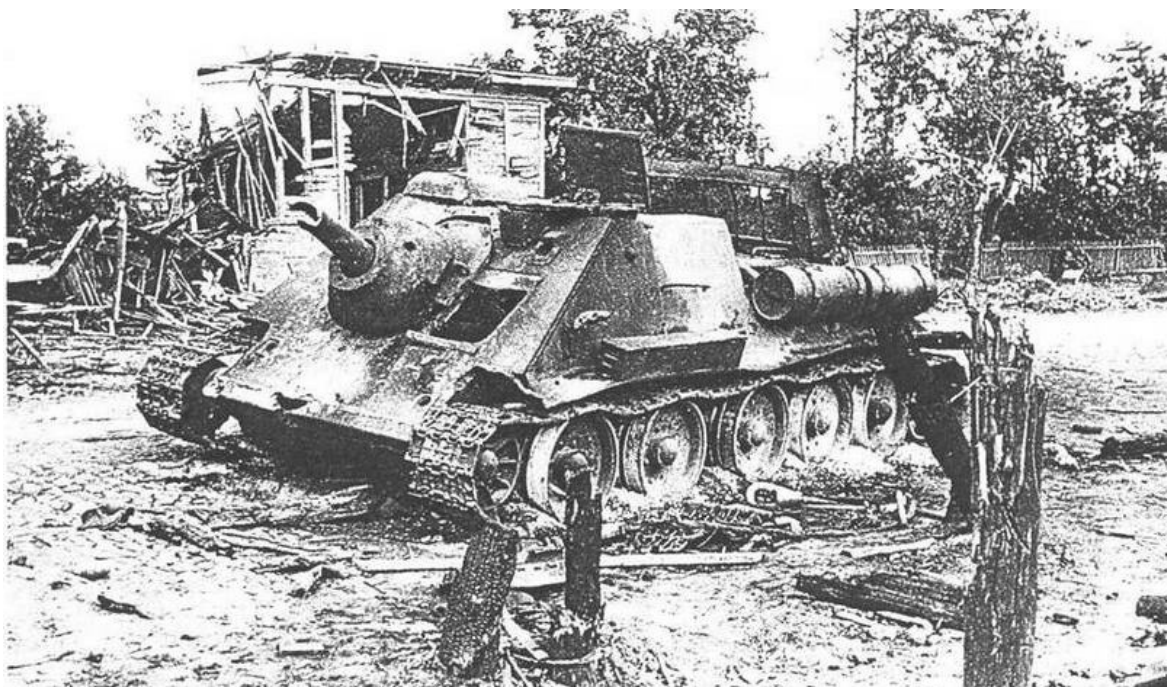
Подбитая СУ-85 на улице Могилева, 1944 год. Судя по отсутствию люка механика-водителя, сорванной с болтов маск-установке и отлетевшей по месту сварки командирской башенке, в машине взорвался боекомплект.
