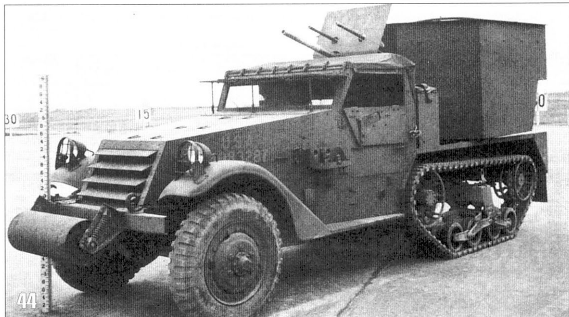
44, 45. Американская зенитная самоходная установка М15 на базе полугусеничного бронетранспортера М3 (фото из коллекции М. Барятинского).
