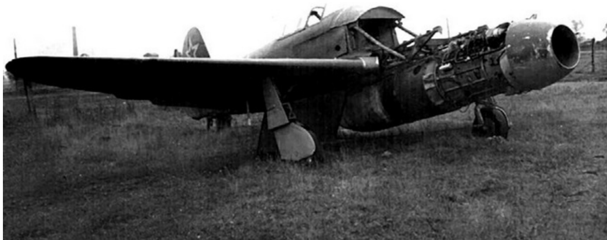
Установка двигателя РД-10 на самолете Як-15.
