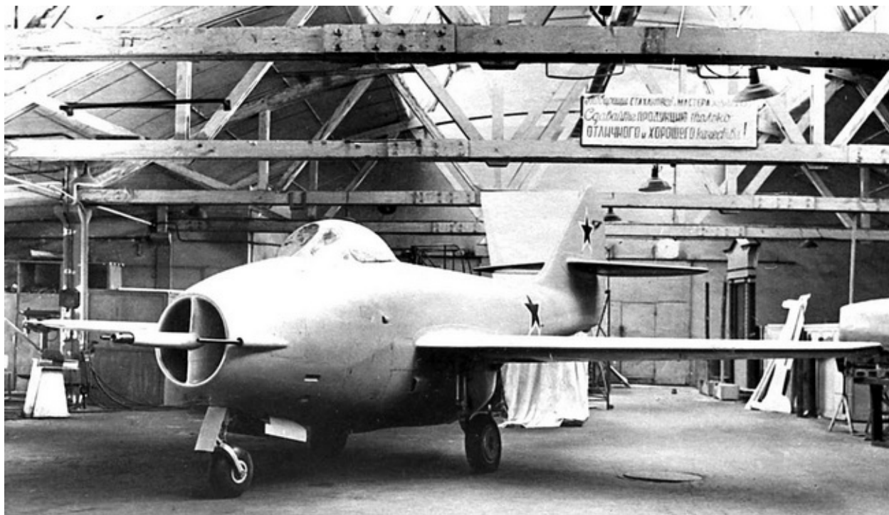
Опытный экземпляр самолета «ФЛ» с двигателем Архипа Люльки.
