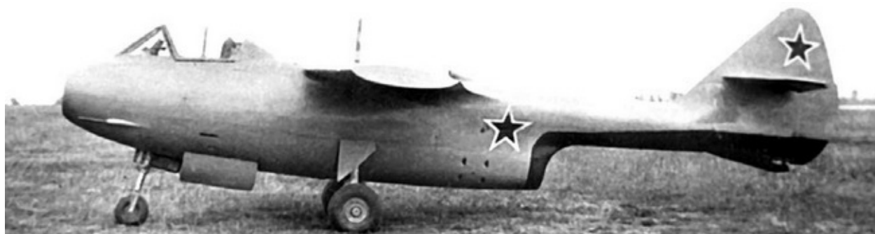
Самолет «150» с отклоненными вниз законцовками крыла и доработанной хвостовой балкой.
