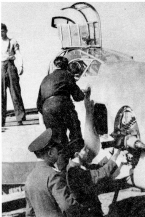
Обслуживание бор- товой пулеметной установки FDL 131 на самолете Me 410
