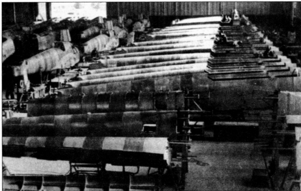
Сборка фюзеляжей Bf 110 на заводе «Мессершмидт» в Аугсбурге
