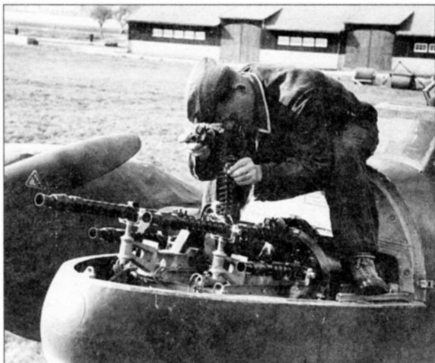
Слева: зарядание пулеметов на Bf 110C Внизу: бортстрелок Bf 110G заряжает пулемет MG 15
