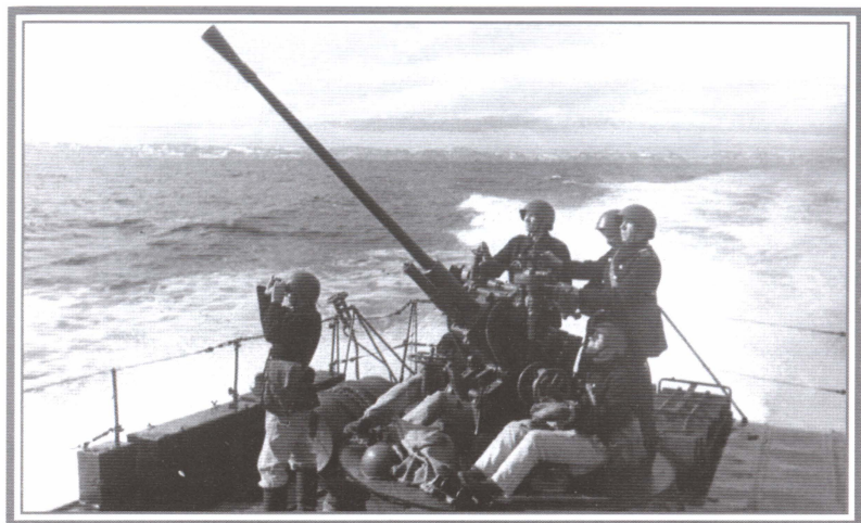
37-мм автомат 70-К — наиболее массовая зенитная установка советского ВМФ периода Великой Отечественной войны
