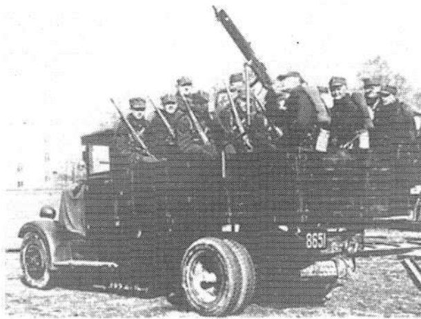
Пехотный взвод 10-й механизированной бригады в рогатыхках с мягкой тульей. Грузовик «Урсус» снабжен зенитным станком для пулемета скт wz.30, выпускавшимся по лицензии американским пулеметом Баунинга калибра .30 с водяным охлаждением.
