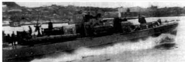
Катер типа GR-301 с торпедными аппаратами
