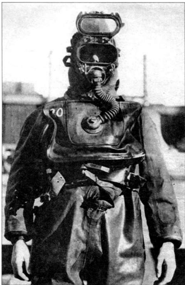
Модернизированный водолазный костюм Слейдена (Mark II). Два кислородных баллона переместились на спину, шлем оснащен маской с одним «окуляром»
