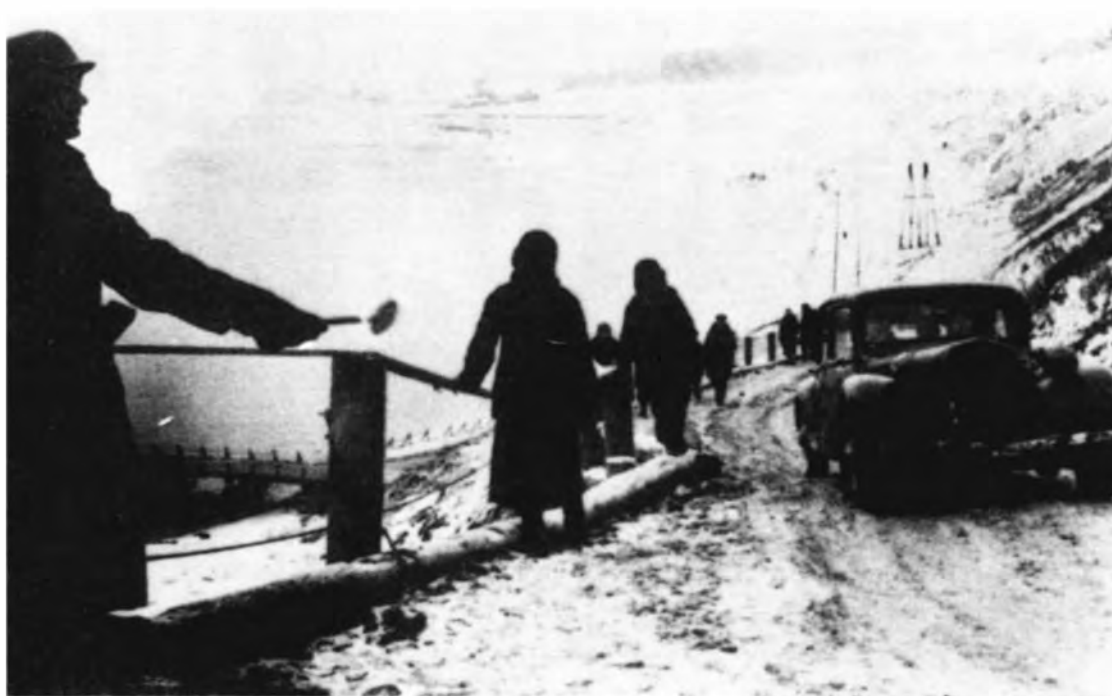
Германская армия предприняла ряд мер в попытке сделать русские дороги зимой проходимыми. Например, на подъемах их посыпали песком, чтобы увеличить силу сцепления колес с дорогой
