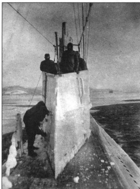
Первый из тихоокеанских «ленинцев» вскоре после вступления в строй, 1936 г. Обратите внимание на первоначальный дизайн рубки, обтекаемый щит 100-мм орудия и отсутствие 45-мм пушки
