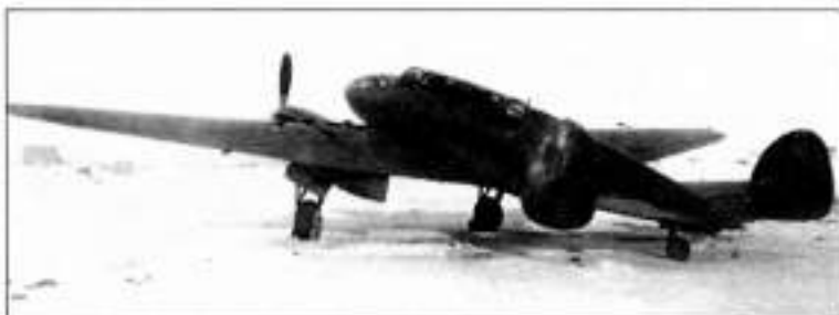
Скоростной пикирующий бомбардировщик СБ с моторами М-105 был создан на базе ВИТ-2
