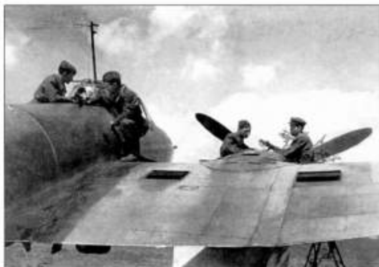
Техническое обслуживание моторов и вооружения «пешки» на аэродроме Красный Холм
