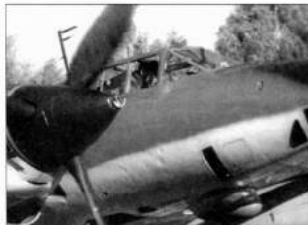
Этот Пе-2 Р ранней постройки (судя по наличию остекления на боковых поверхностях носа фюзеляжа) оборудован радиополукомпасом РПК-2 «Чайка» с каплевидной антенной под кабиной пилота
