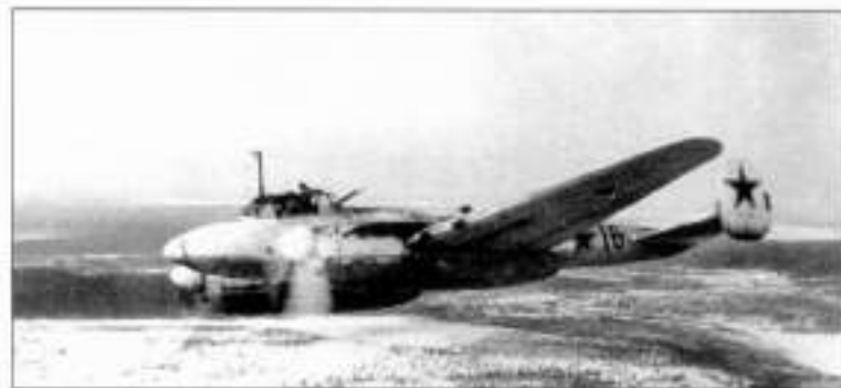
«Пешка» из 2-й эскадрильи 12-го гв. бап в зимней камуфляжной окраске. Машина поздней модификации с мачтой антенны, перенесенной на козырек кабины, и индивидуальными патрубками моторов
