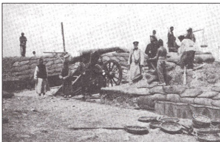
Постройка заредутной батареи в Порт-Артуре
