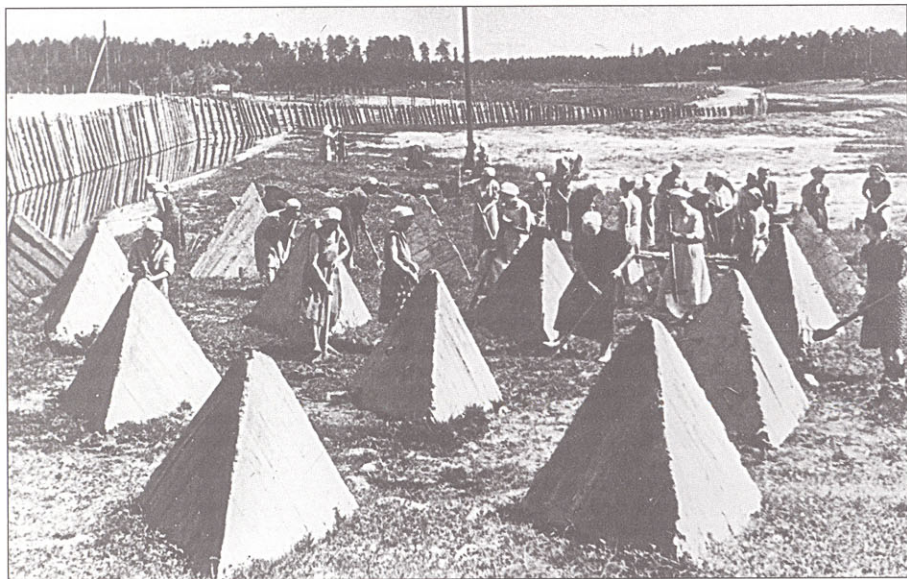
Надолбы, ров и стенка на танкоопасном направлении
