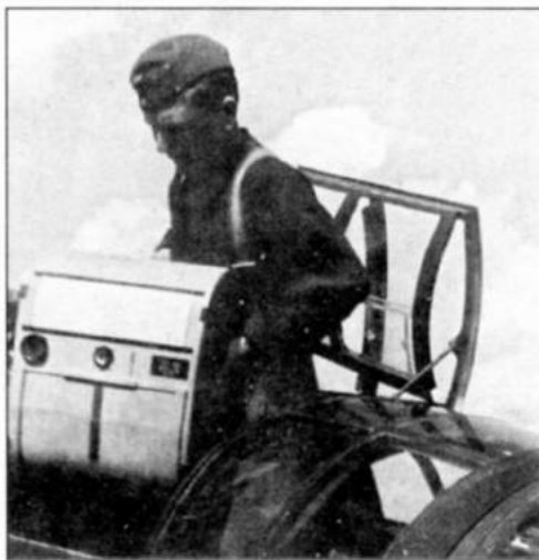
Замена кассеты с пленкой панорамного фотоаппарата
