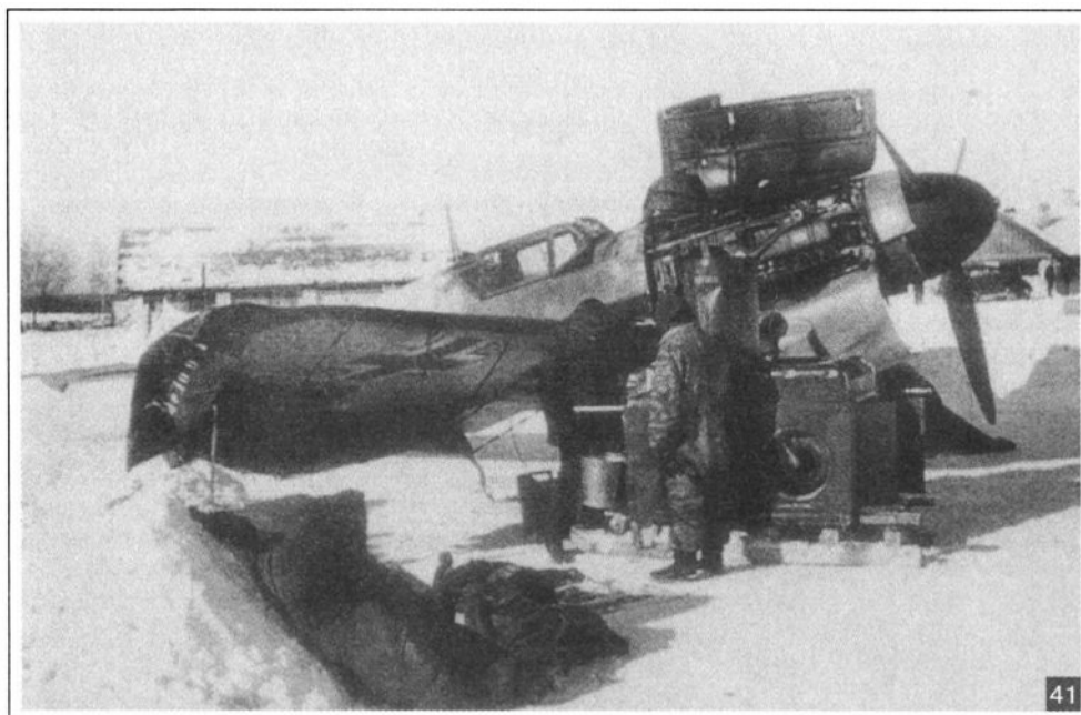
41. Немецкие механики у раскапченного мотора DB601N, установленного на Bf109F-2. Обращает внимание наличие на аэродроме электрообогревателя и других приборов, которые стали широко применяться на Восточном фронте в конце зимы 1942 г.
