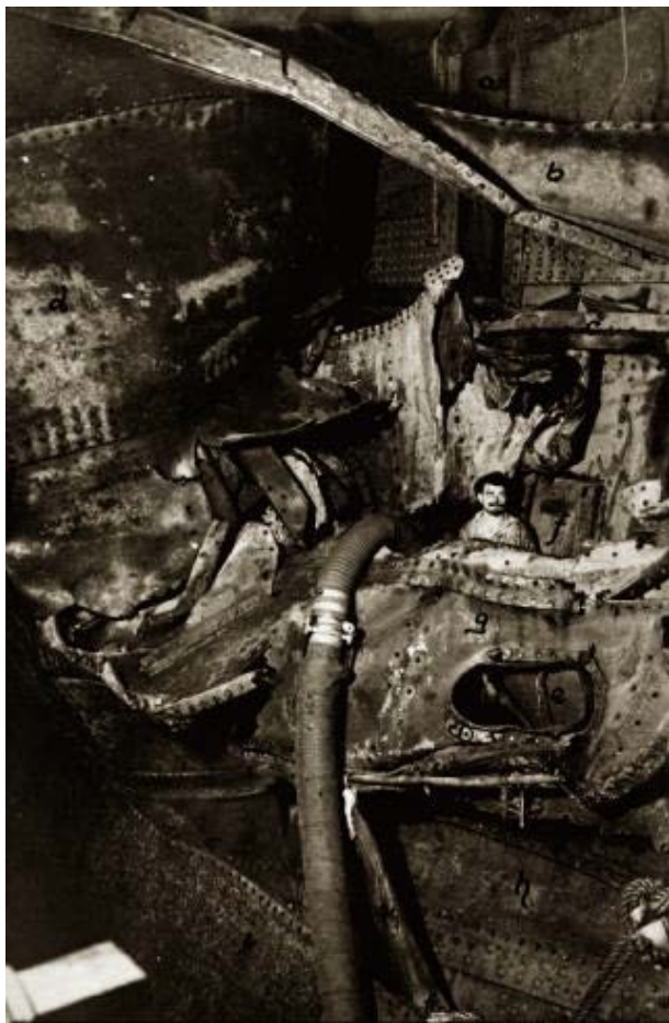
Фото 59. Дренаж поврежденного отсека после подрыва «Гебена» на mine
