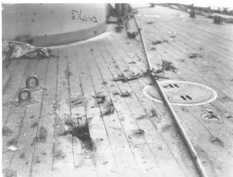
Фото 27. Линейный крейсер «Фон дер Танн». Осколочное поражение палубы
