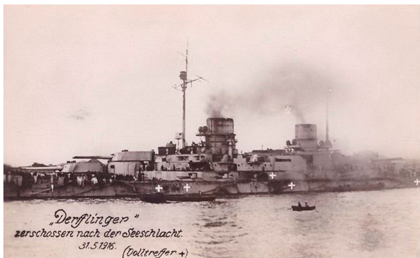
Фото 89. Линейный крейсер «Дерфлингер». На фото отмечены крестами точки попаданий снарядов
