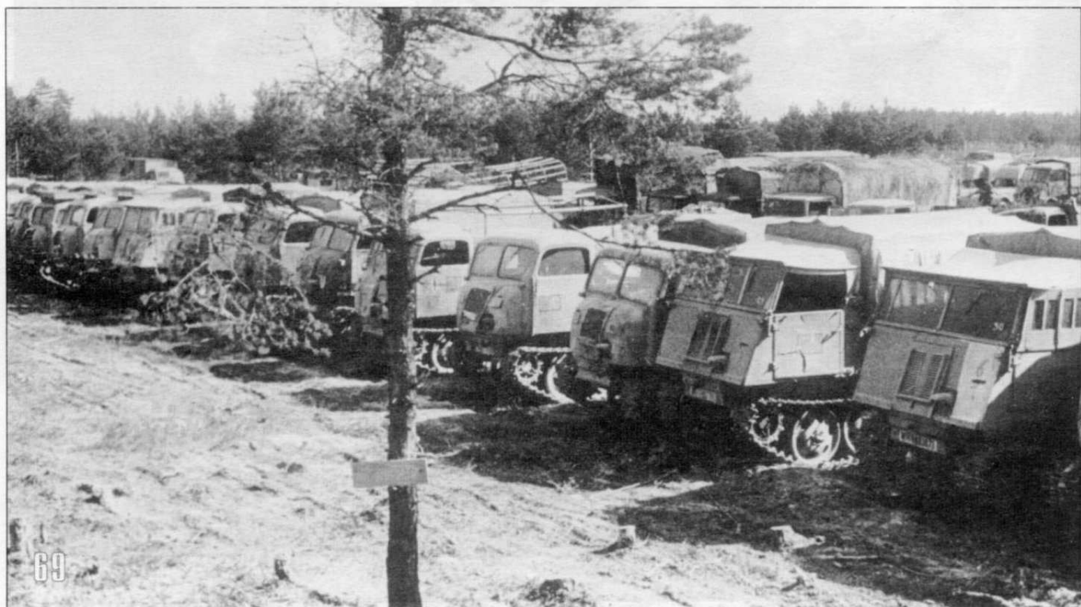
69. Артиллерийские тягачи RSO различных модификаций. Капитуляция немецких войск в Курляндии, май 1945 года. Номер крайнего справа RSO/03 с "угловатой" кабиной (тактический номер "6" в белом прямоугольнике, регистрационный номер "WH-1883873"). Various versions of the RSO artillery tractor. German troops capitulating in Kurland, May 1945. The right-most RSO/03 with the angular cab has tactical number 6 within the white rectangle and registration number WH-1883873.
