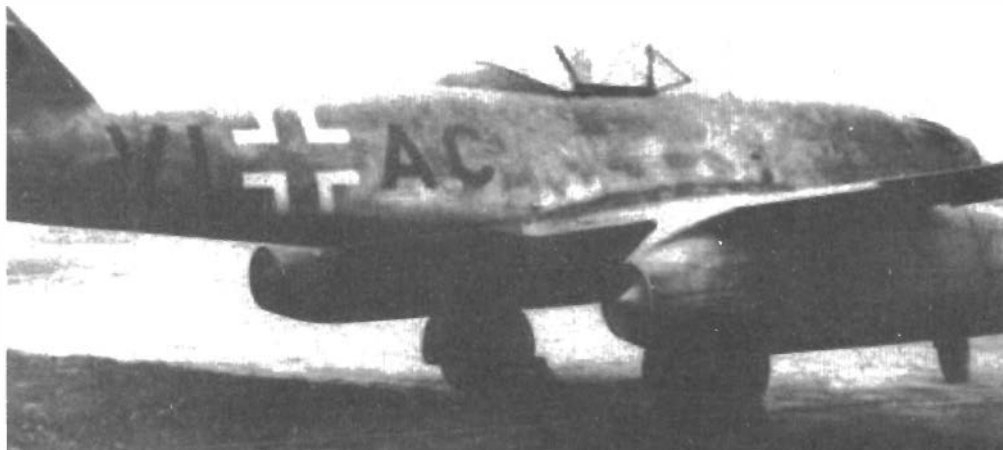
Тестовый Me.262V8 с установленными ускорителями RI 502
