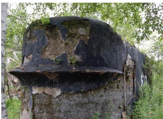
Конструктивно памятник повторял форму и очертания ограждения рубки подводной лодки проекта 629А. Памятник был выполнен из бетона, в настоящее время практически полностью разрушен.
