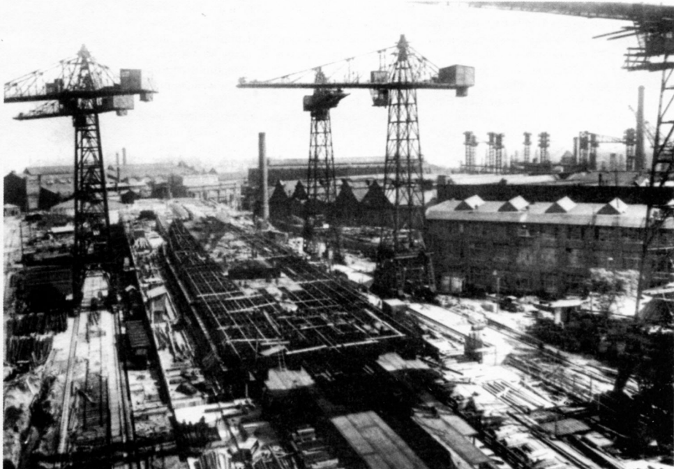
Днищевый набор корпуса линкора «Советский Союз» на стапеле судостроительного завода №189. Ленинград, июль 1939 г.
