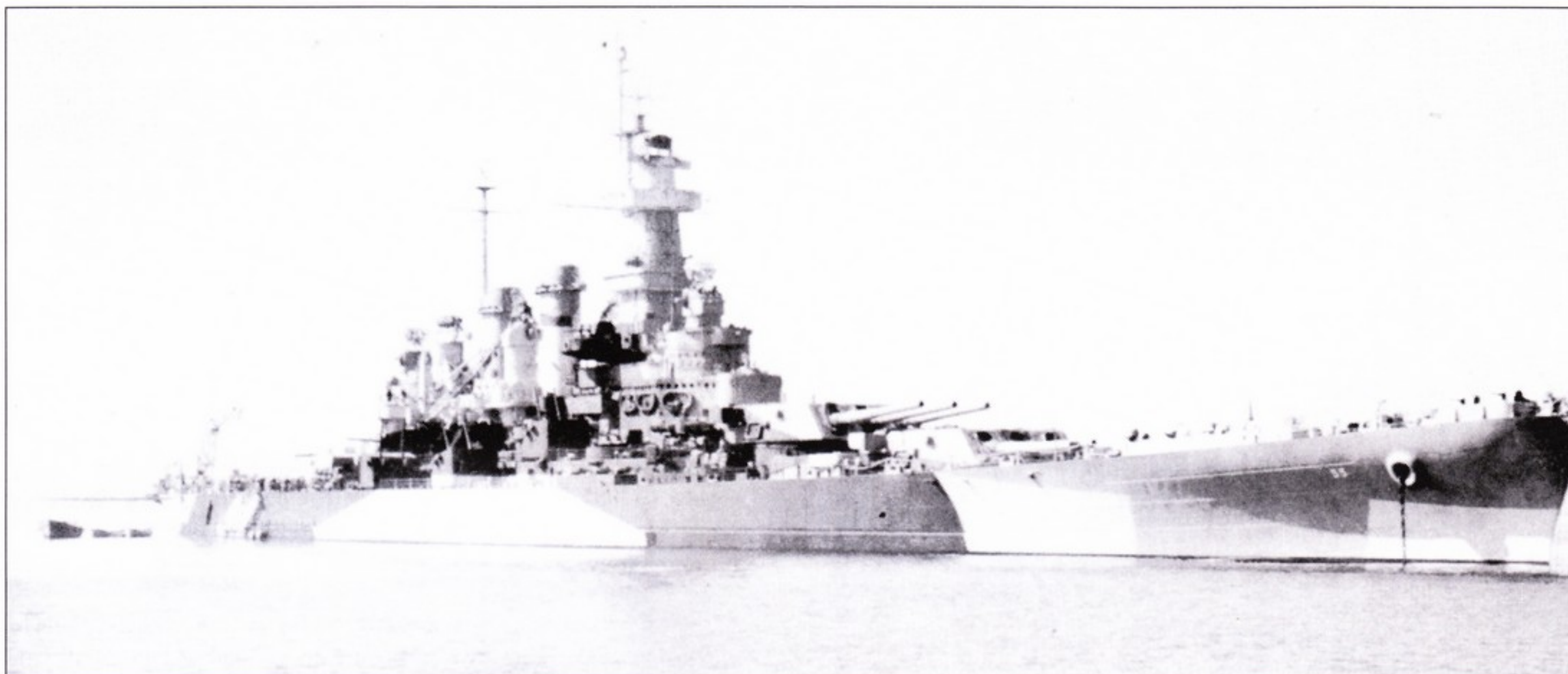
В конце лета 1944 г. «Северная Каролина» прошла интенсивный ремонт, в ходе которого на корабле серьезно обновили радиолокационное оборудование. Вместо РЛС FD установлена РЛС Mk. 12/22, вместо РЛС SC - РЛС SC-2. Камуфляж изменен.
