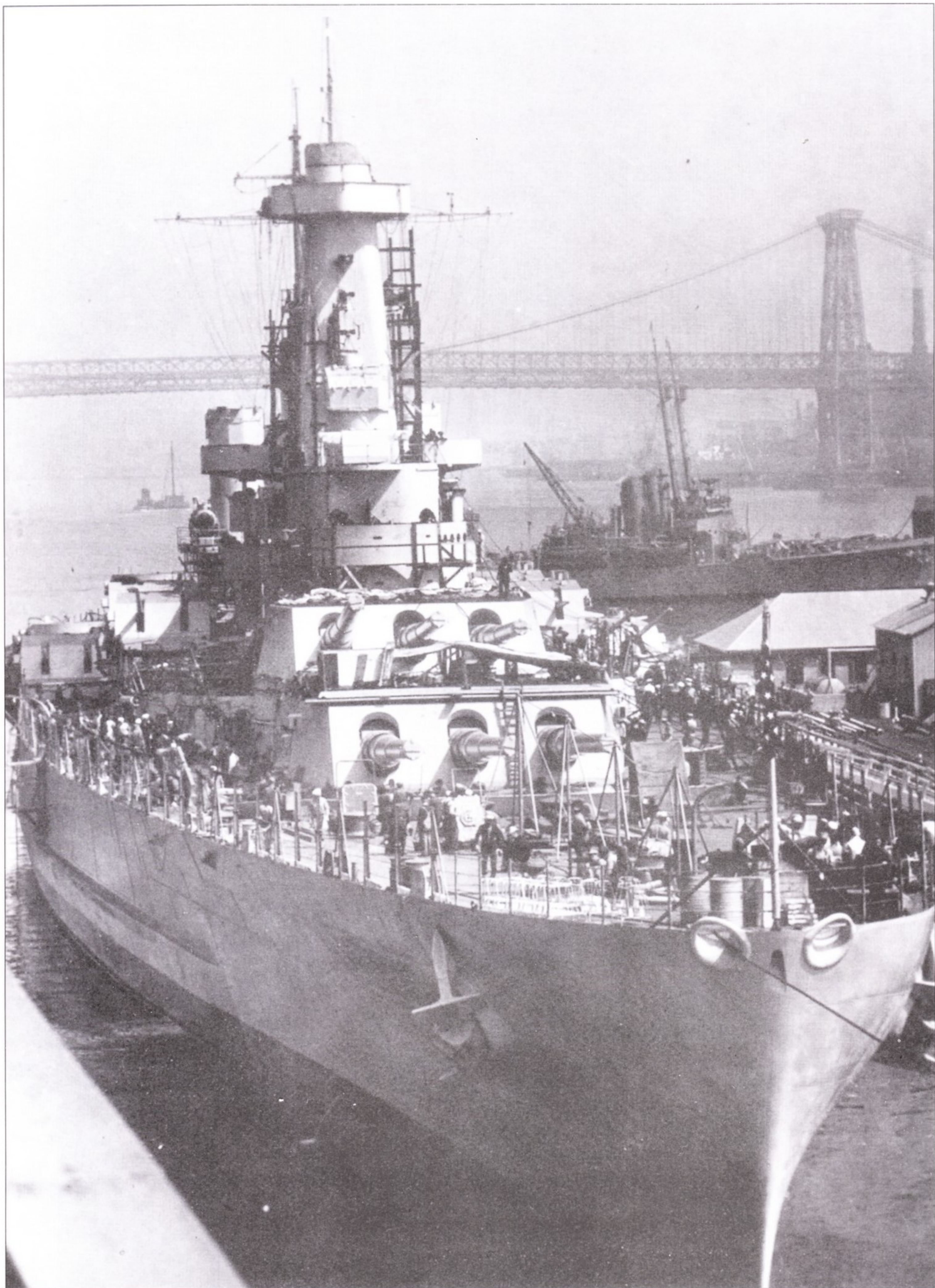
Линкор «Северная Каролина» на окончательной стадии постройки, Нью-Йорк, начало 1941 г. установлена основная и вспомогательная артиллерия, зенитной артиллерии пока нет. Вокруг надстройки - леса.
