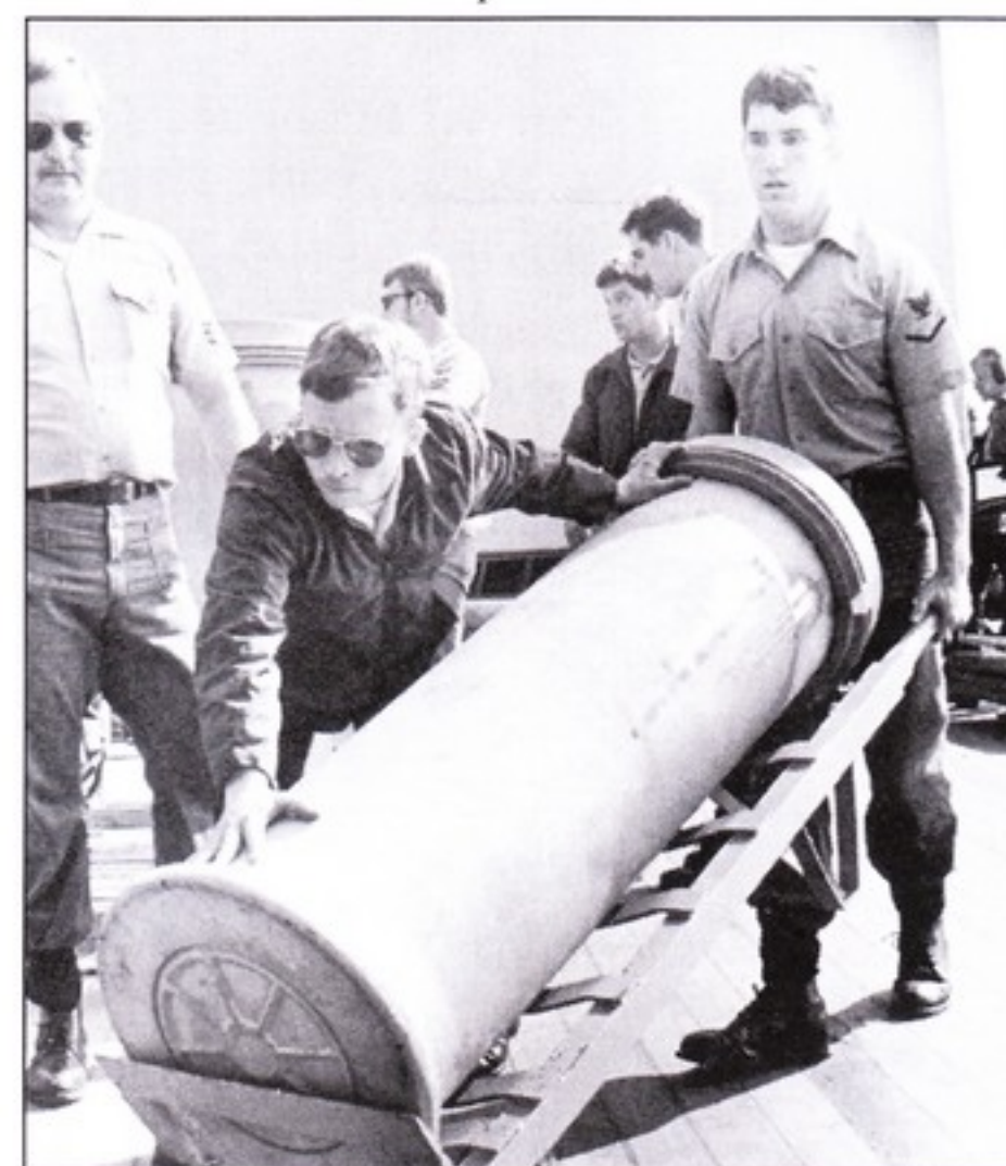
Новый пороховой заряд с пониженной температурой горения был впервые использован для стрельбы главным калибром на линкоре «Нью Джерси» во Вьетнаме. На снимке - моряки линкора с таким зарядом, масса заряда 655 фунтов.
