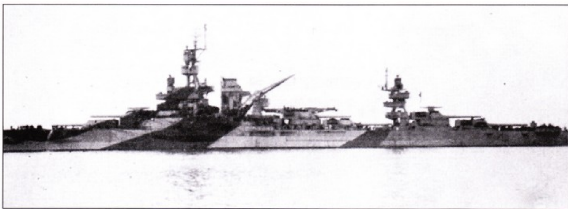
Боевая служба в Атлантике завершилась для «Арканзаса» постановкой на ремонт в Бостоне 5 ноября 1944 г. На фок-мачте корабля видны антенны радиолокаторов SM, SG, FC. Антенна РЛС SG установлена также на грот-мачте, дублирование - обычная практика, связанная с ненадежной работой радаров данного типа. Радиолокатор SG был предназначен для управления огнем артиллерии среднего калибра. На снимке хорошо видна дальнометры, установленные на крышах двух башен главного калибра; с двух других башен дальнометры сняты.
