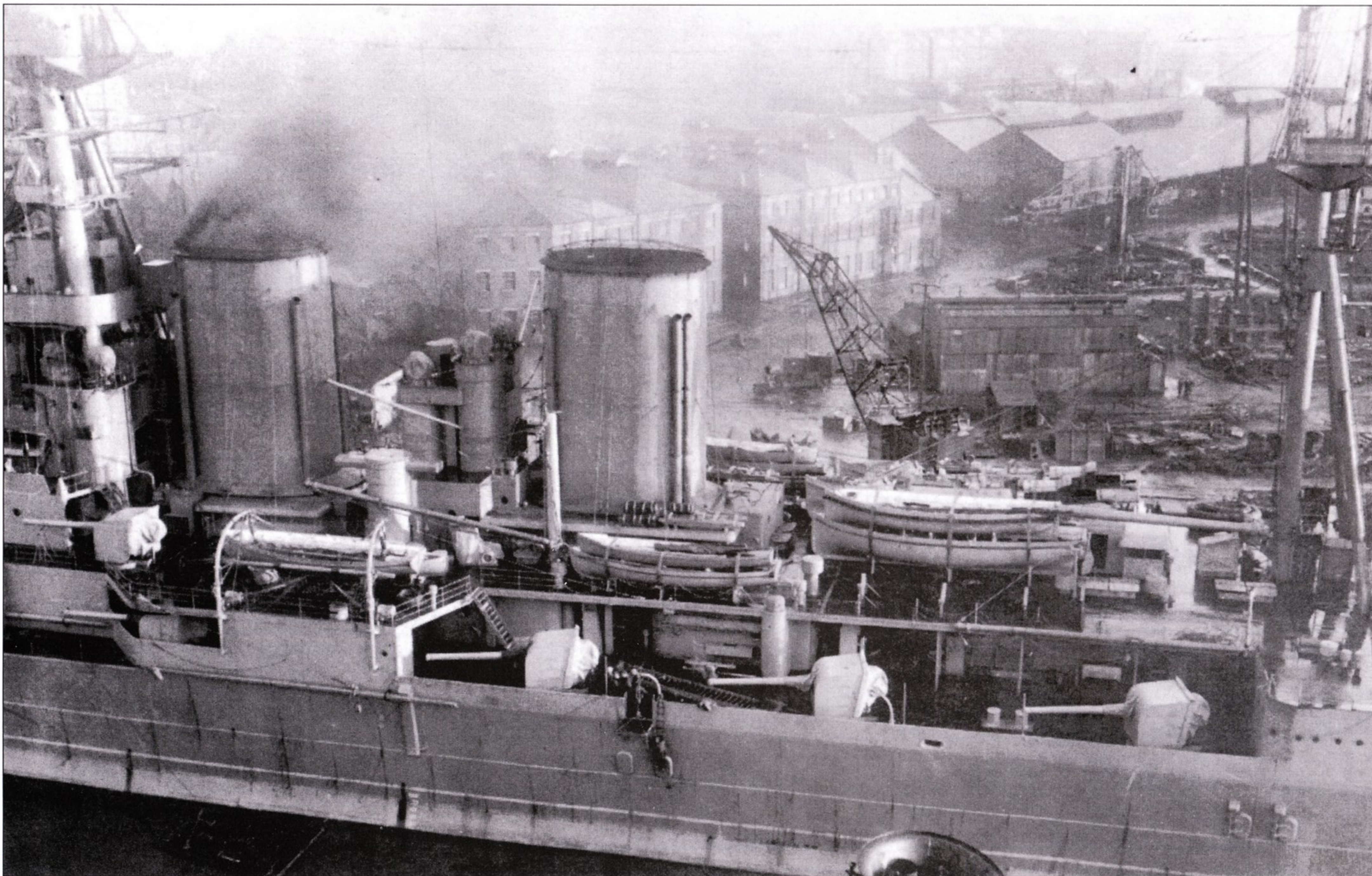
Вид сверху сбоку шелтер-дека линейного крейсера «Худ», шлюпочной палубы. В кадр попали орудия среднего, 5,5 дюймов, калибра. Такие пушки стояли не только на «Худе», но также на легком линейном крейсере «Фьюриес», легких крейсерах «Биркенхед» и «Честер». В нижней правой части фотографии в борту «Худа» крейсера видны крышки двух надводных торпедных аппаратов.
