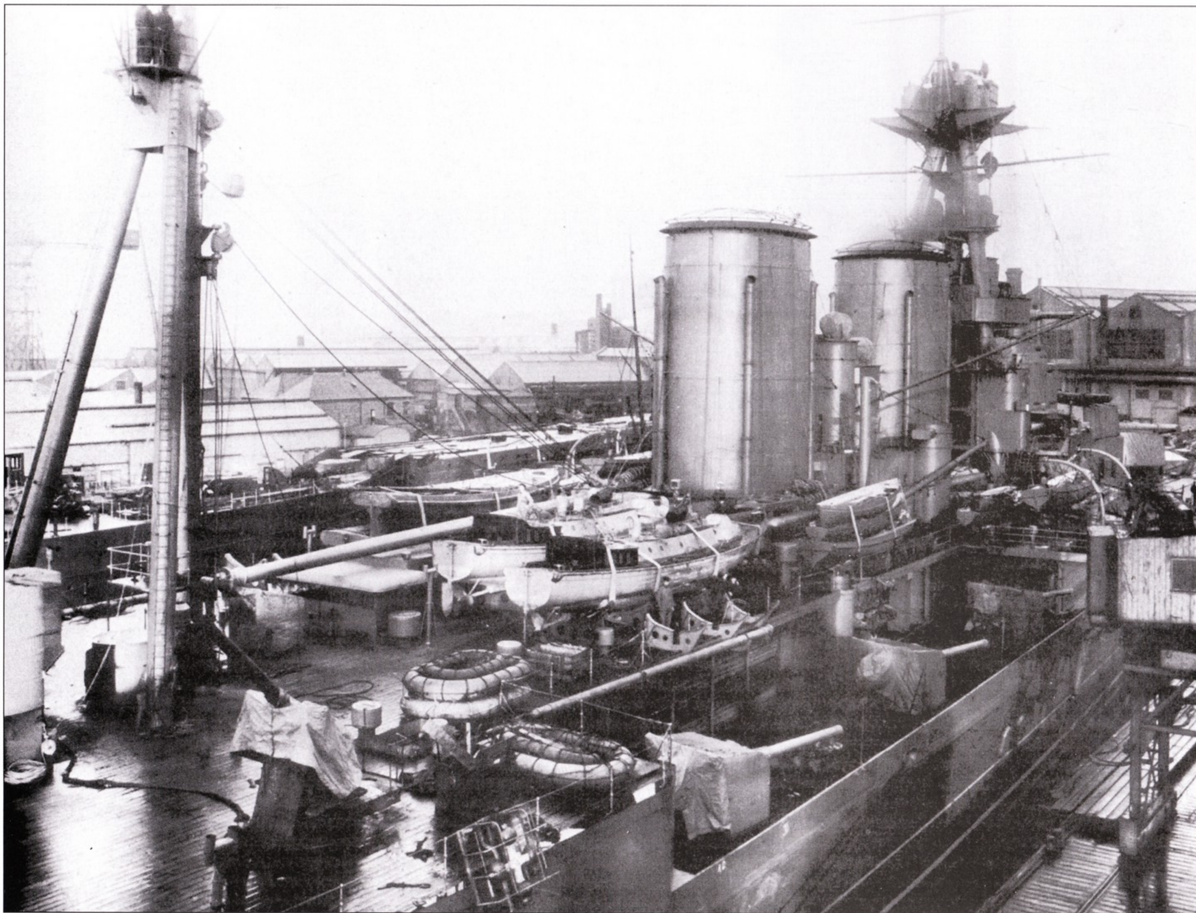
Общий вид шелтер-дека, также известного как шлюпочная палуба. По борту установлены пушки среднего, 5,54 дюймов, калибра. Фигурки рабочих на мачте подчеркивают огромность корабля.
