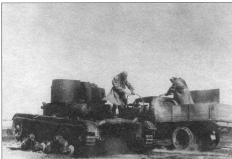
Вверху: танк Т-26 с танковыми химическими приборами ТХП-3. Внизу: заправка приборов ТХП-3 во время испытаний
