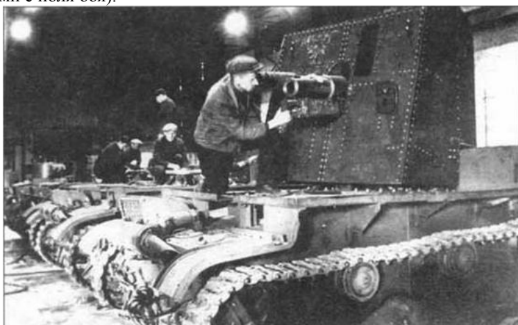
В блокадном Ленинграде на шасси ремонтируемых танков Т-26 изготавливались самоходные установки, вооруженные 76-мм полковыми пушками. 1942 г.
