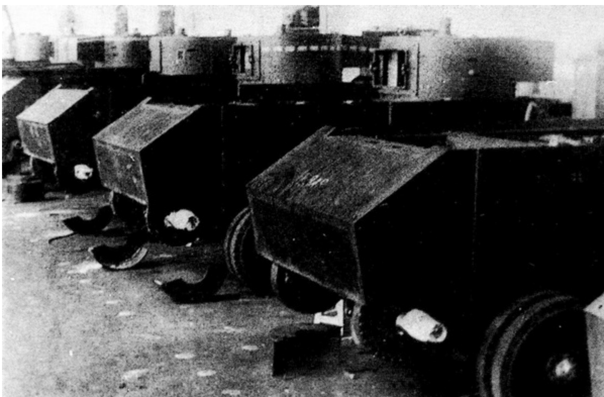
Сборка танков БТ-ИС на базе БТ-5 на заводе № 48. 1936 год.
