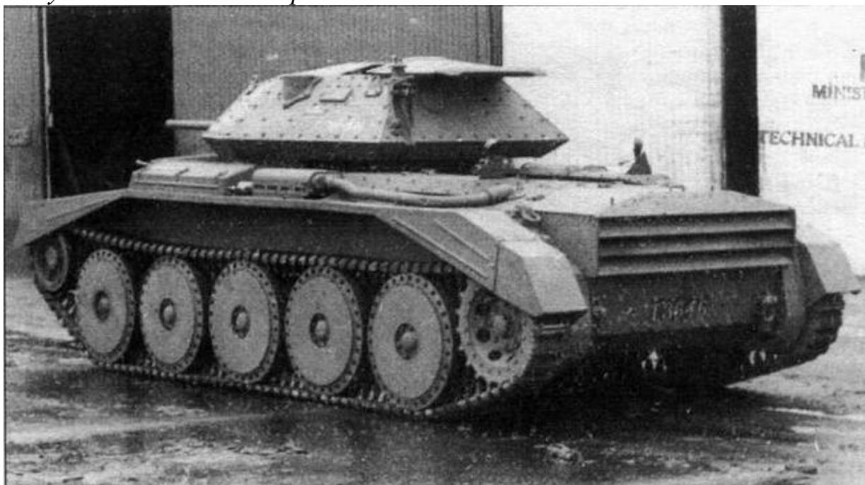
*На этом снимке прототипа «Крусейдера» видно еще одно отличие от серийных машин — установка глушителя в средней части надгусеничных полок*
