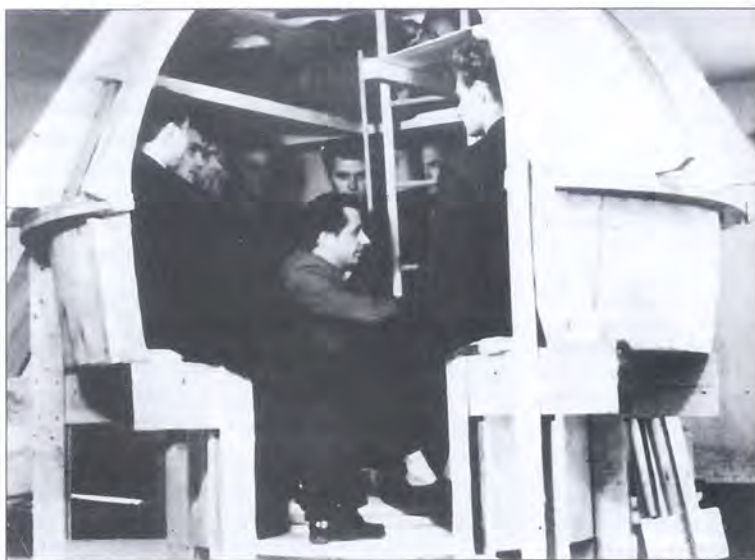
Макетирование всплывающей специальной камеры
