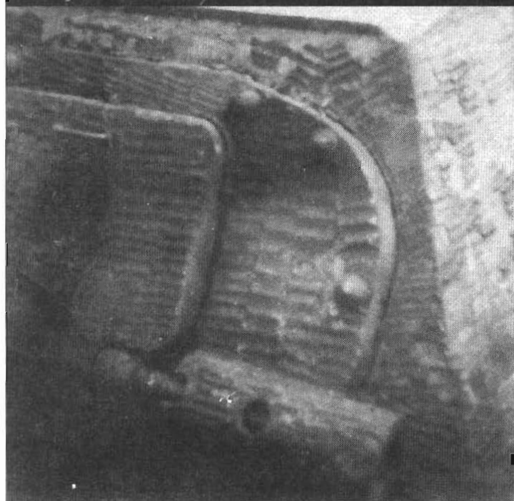
На фото представлены «Королевские Тигры» с башней Порше. Машины выпуска апрель-май 1944 г. из 1-й роты 503-го тяжелого танкового батальона. Обратите внимание на составной ствол орудия, монокулярный прицел наводчика и боевые гусеницы Gg 26/800/300. Торсион кормового башенного люка защищен полукруглыми броневыми накладками, которые тоже покрыты циммеритом.
