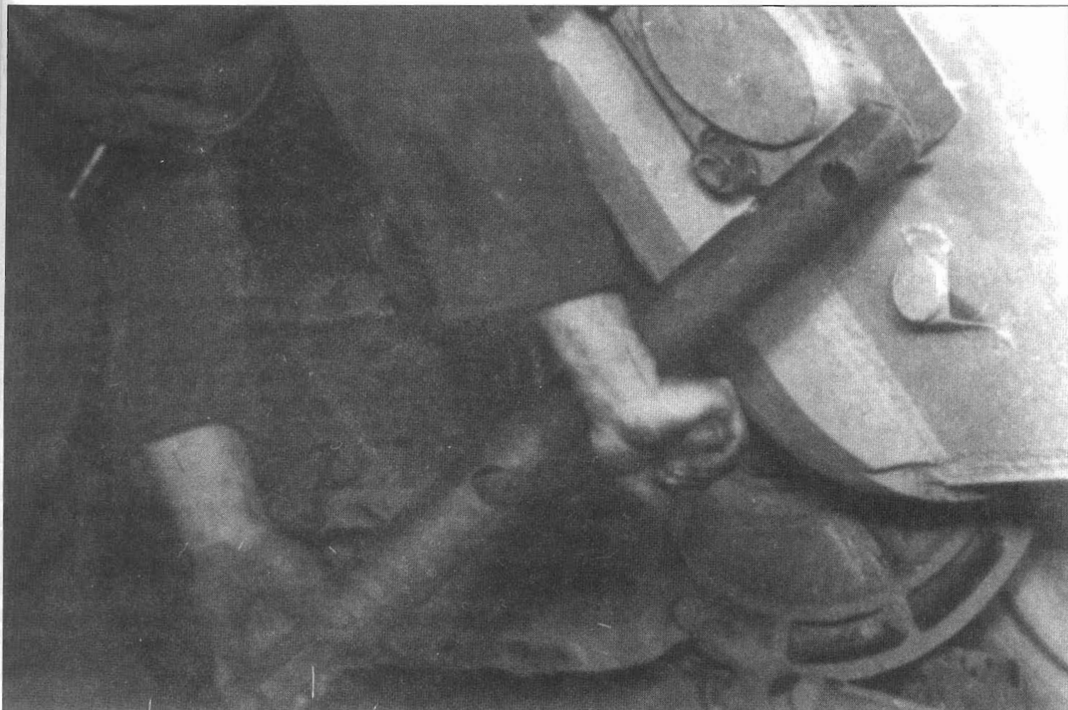
Регуляция положения опорных катков проходила через люки в кормовой бронеплите с помощью специального ключа.
