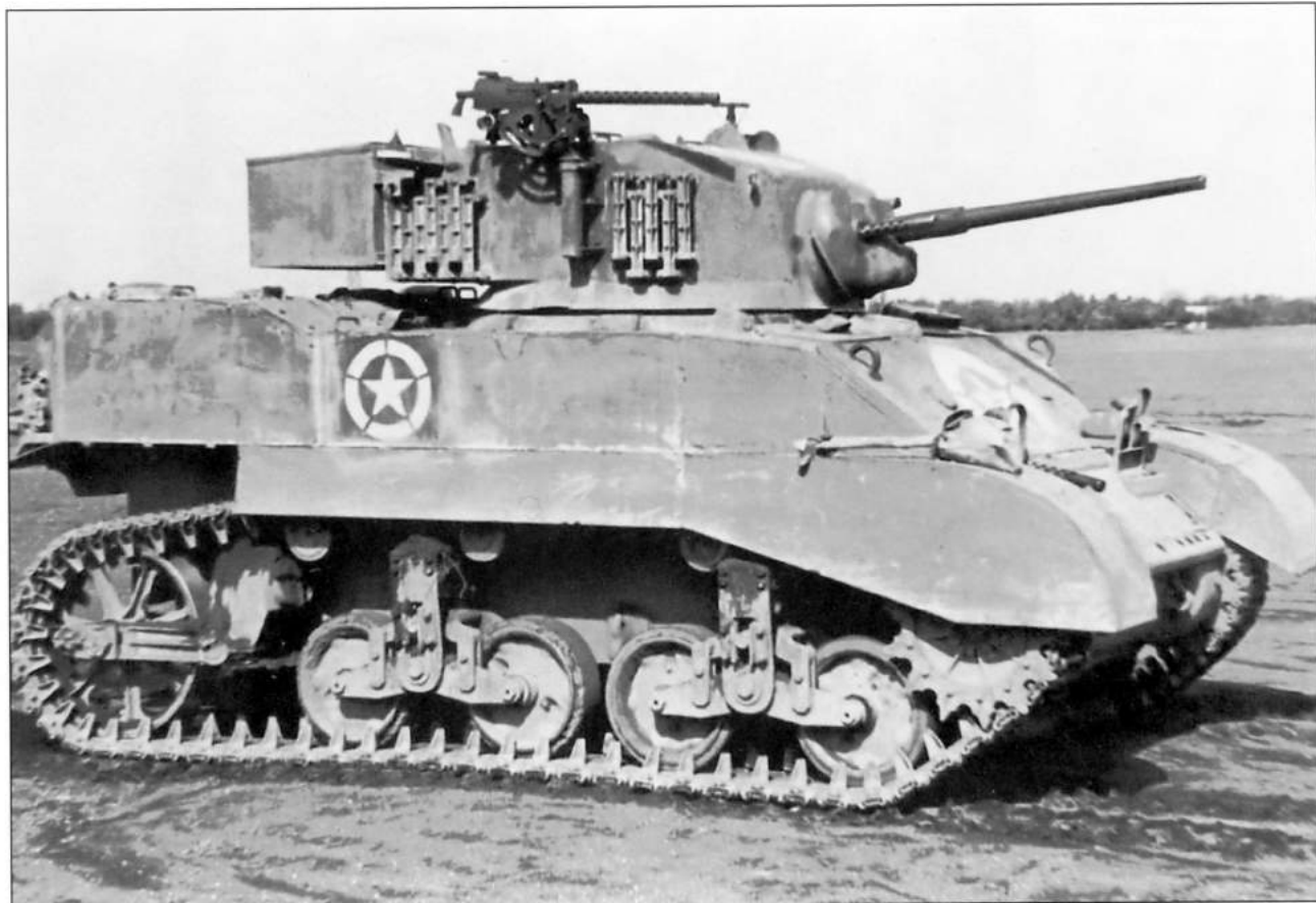
Легкий танк М5А1 позднего выпуска (с крыльями и штампо- ванными опорными катками)
