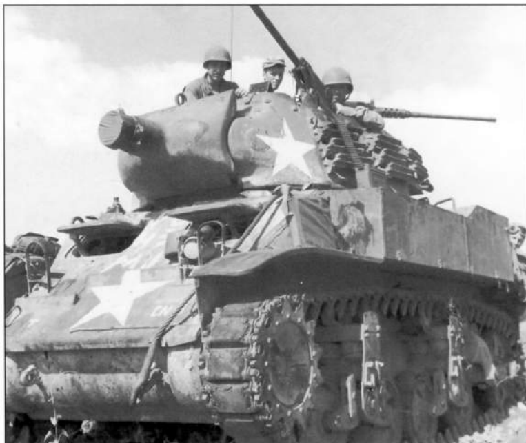
На части танков М3А1 огнемёт был установлен не в башне, а в корпусе, вместо курсового пулемёта. При этом основное вооружение – 37-мм пушка – сохранялось
