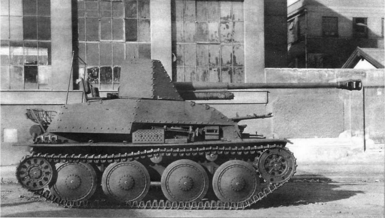
Истребитель танков Sd.Kfz.139 «Мардер III» в боевом положении. Стопор пушки откинут
