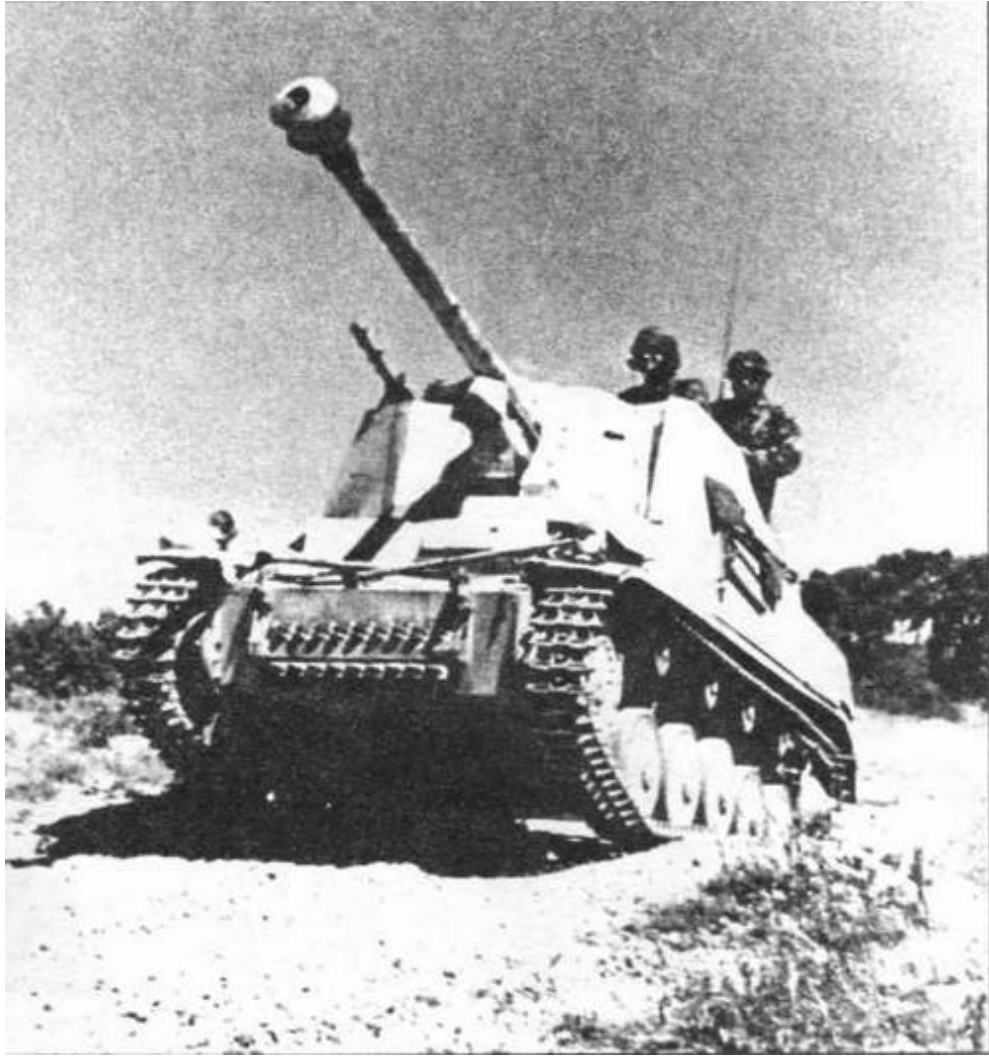
Истребитель танков Sd.Kfz.131. Восточный фронт, 1943 год. Обращает на себя внимание пулемет MG34, установленный на правом борту рубки
