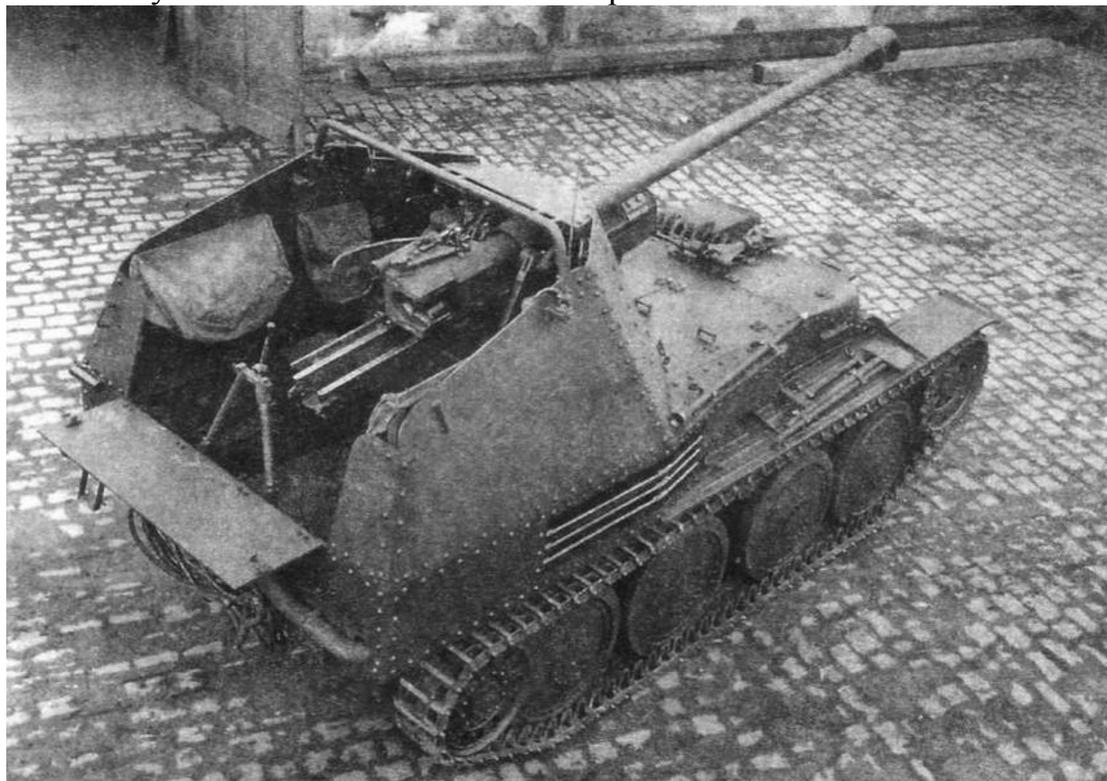
Истребитель танков «Мардер III» Ausf.M. Кормовая стенка рубки откинута в горизонтальное положение
