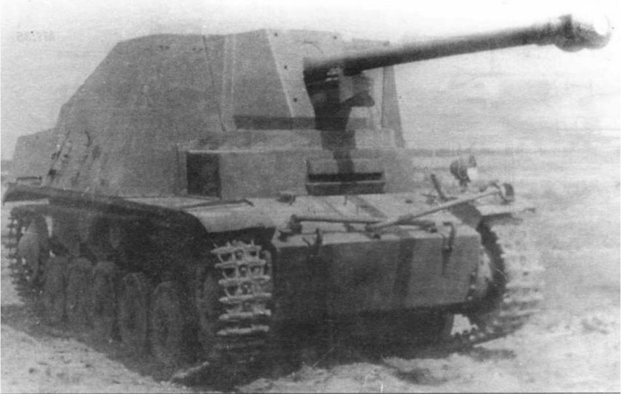
Самоходная установка Sd.Kfz.131 «Мардер II» на НИБТ Полигоне в Кубинке, 1946 год. Штанги стопора пушки уложены на верхний лобовой лист корпуса в положение по-боевому
