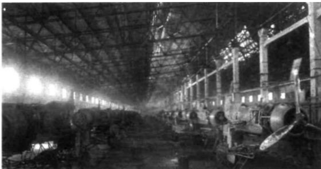
Сборка самолетов Ла-5 на заводе 21. 1943 год. На пике про- изводства завод способен был выпускать до 15 подобных машин в сутки.
