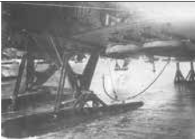
Р-1 часто использовали для буксировки мишеней-рукавов. На подкрыльных бомбодержателях этого самолета – комплект мишеней ШТ-42, декабрь 1930 г.
