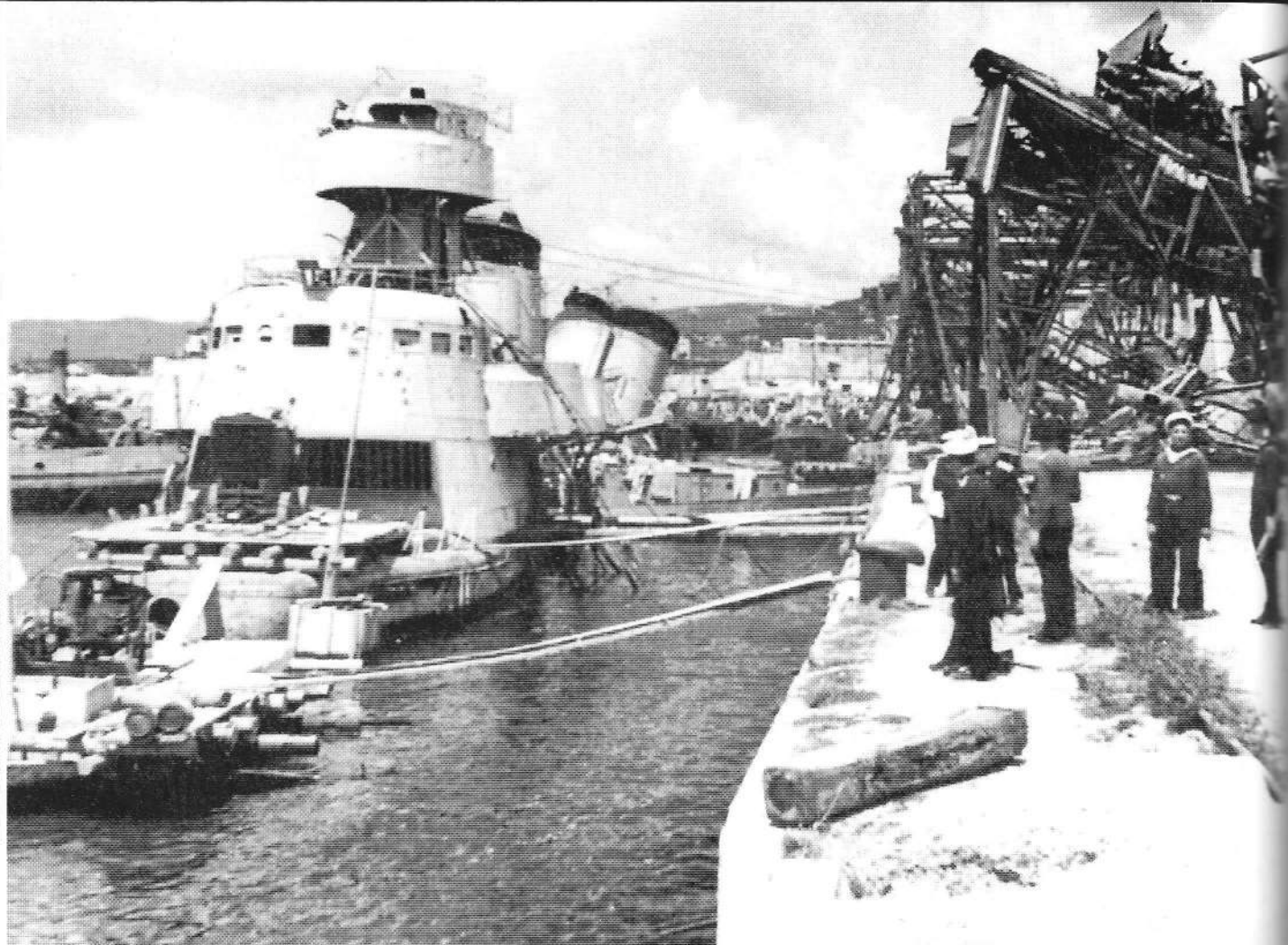
Постановка затонувшего лидера на ровный киль (вверху) и его буксировка на отмель для заделки пробоин. Новороссийск, август 1944 г.
