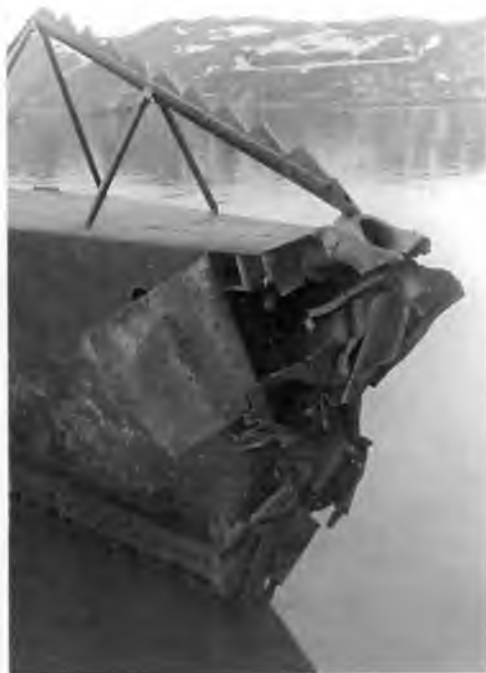
Подводная лодка С-55 после возвращения из боевого похода. Хорошо видны повреждения, полученные от взрывов глубинных бомб 29 апреля 1943 г.
