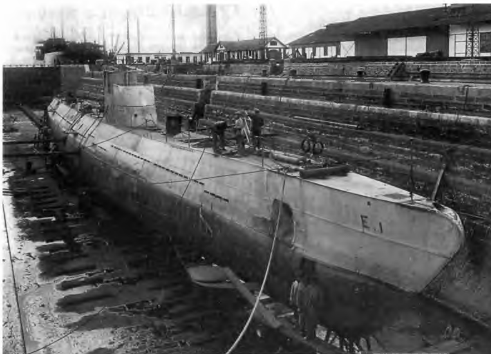
Непосредственный прототип «эски» — подводная лодка Е-1. В 1936 г. она была продана Турции и под названием «Гюр» служила до 1949 г. В н и з у: схема общего вида субмарины
