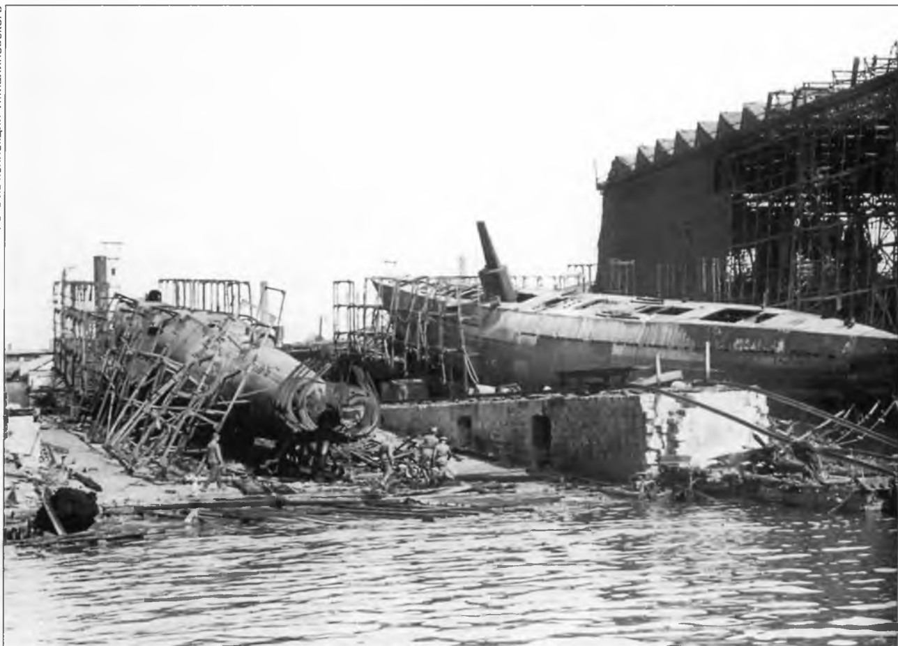
Корпуса подводных лодок С-36 и С-37, брошенные на стапеле завода имени А.Марти в Николаеве, август 1941 г.
