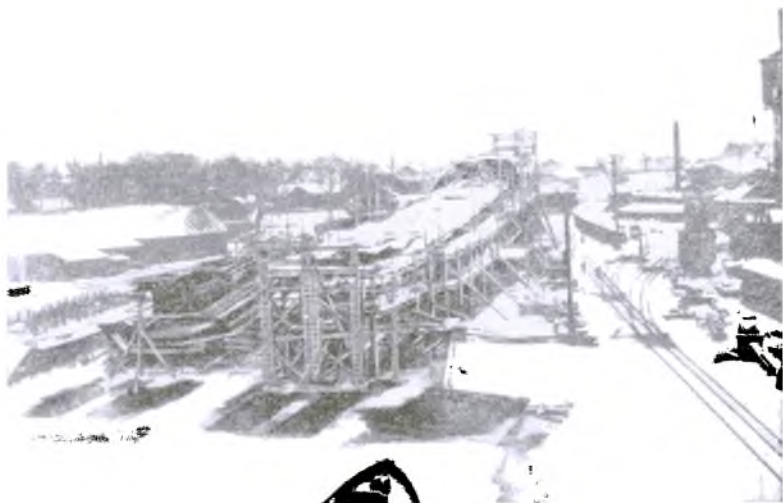
Проверка корпуса на водо- и нефтенепроницаемость, январь 1911 г.
