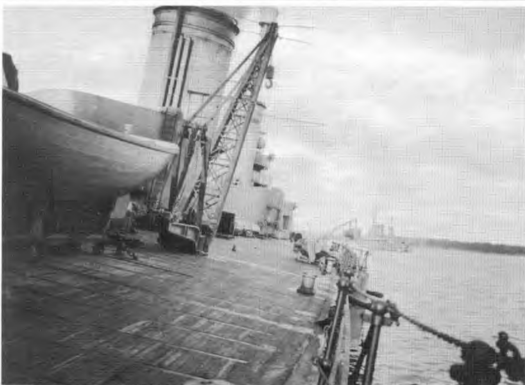
“Петропавловск” во время кренования при определении метацентрической высоты
