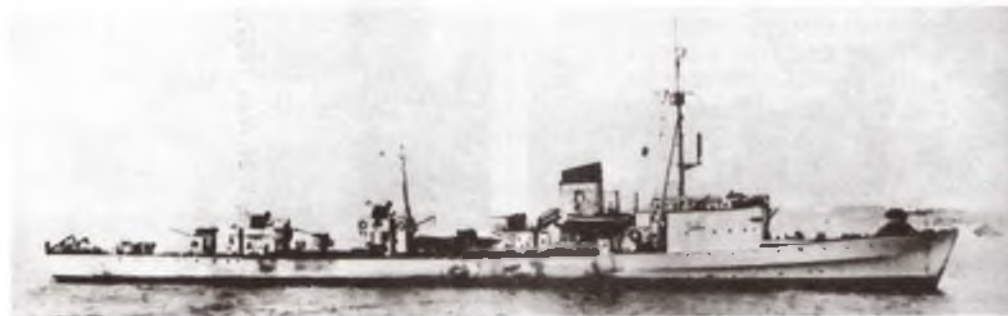
Т-19 в конце войны. Миноносец несет 40-мм «бофорс» вместо кормового торпедного аппарата, 37-мм автоматы на носу и позади дымовой трубы, а также 20-мм «фирлинги» на средней и кормовой надстройках
