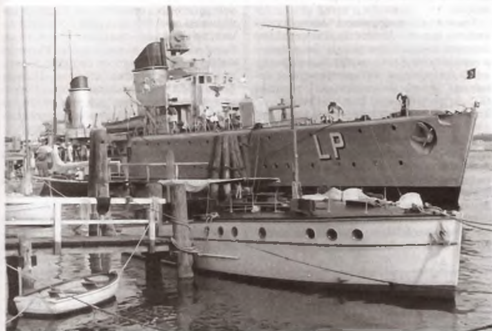
«Леопард» после перевооружения 127-мм орудиями C/34
