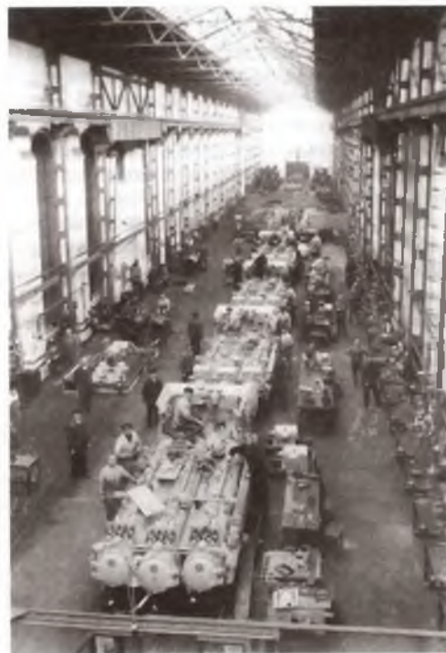
Производство торпедных аппаратов в военноморском арсенале Киле
