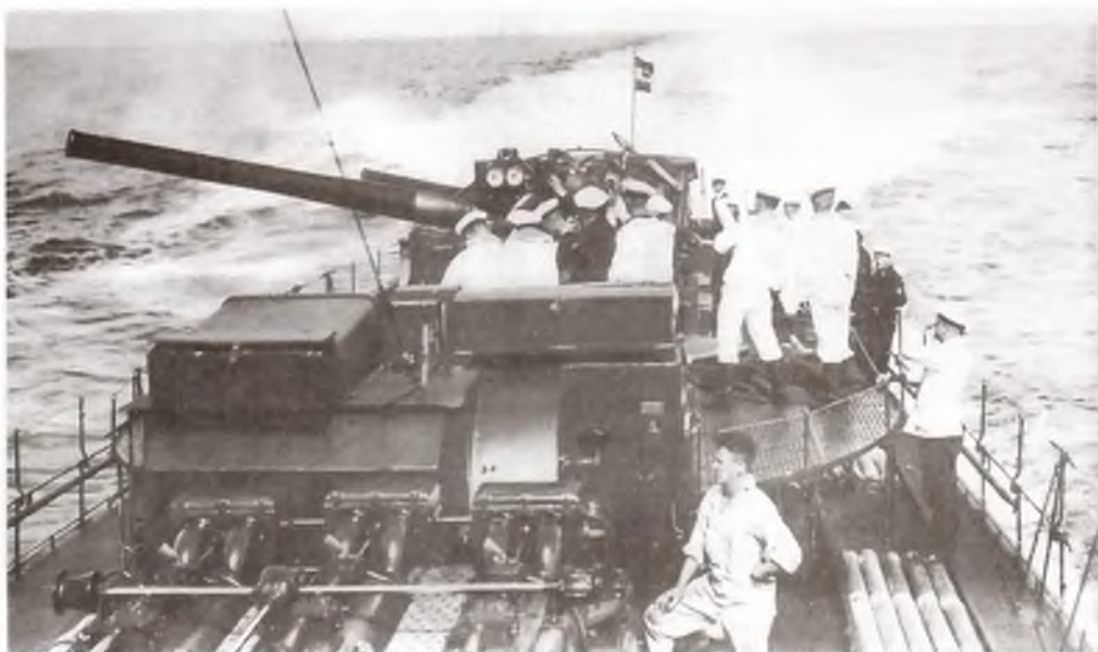
105-мм орудие Utof L/45 миноносца «Кондор»
