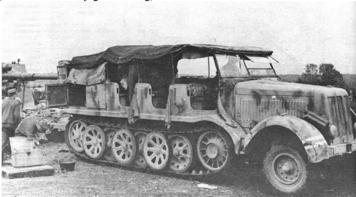
12-тонный тягач Sd.Kfz.8 с 88-мм зенитной пушкой Flak 36
