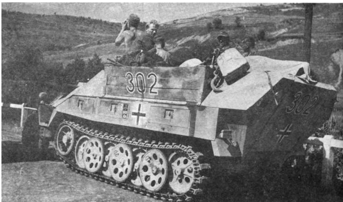
Бронетранспортер инженерных войск Sd.Kfz.251/7 Ausf.D
