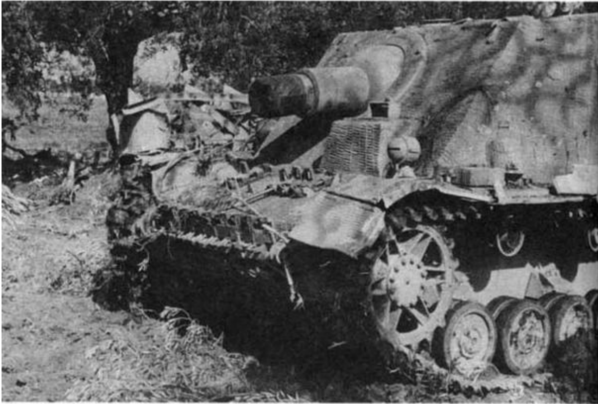
Штурмовой танк Grtmtbär средних выпусков — в распоряжении механика-водителя уже имеется рубка с перископическим прибором наблюдения, но курсовой пулемет еще отсутствует
