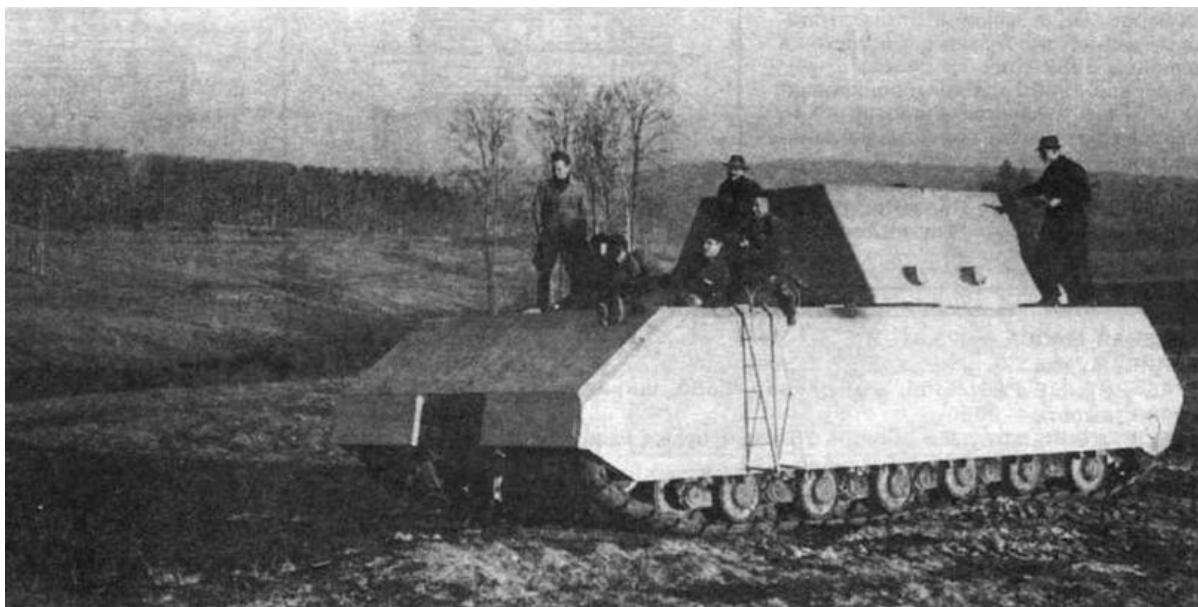
Сверхтяжелый танк Maus во время полигонных испытаний. Вместо башни установлена неподвижная балластная рубка. 1944 год
