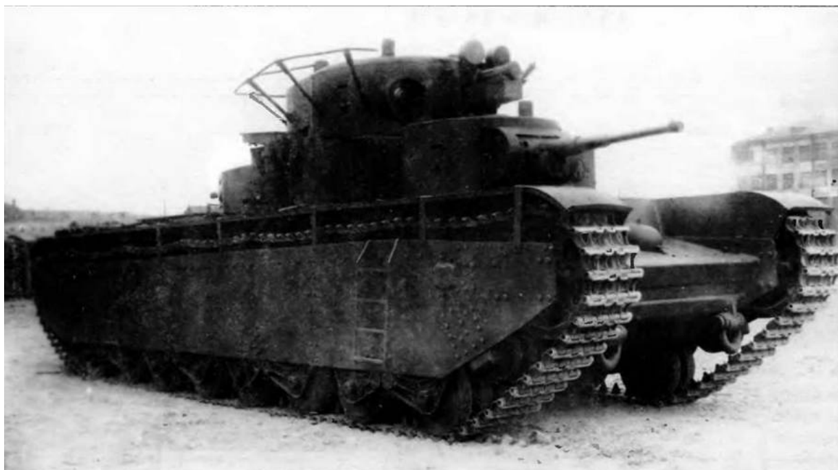
Тяжелый танк Т-35А. Все машины этого типа были оснащены радиостанциями 71-ТК-1 с поручневыми антеннами
