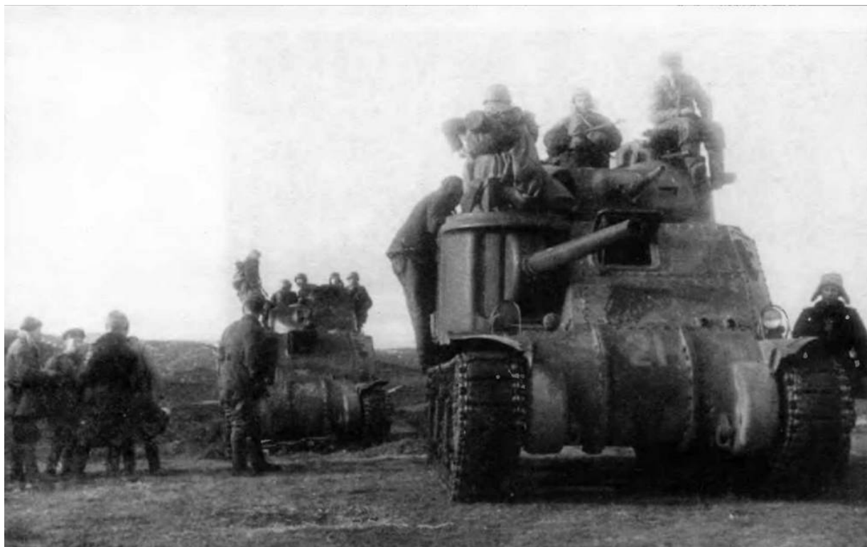
Средние танки МЗс, оснащенные 75-мм пушками МЗ. Карельский фронт, 1944 год
