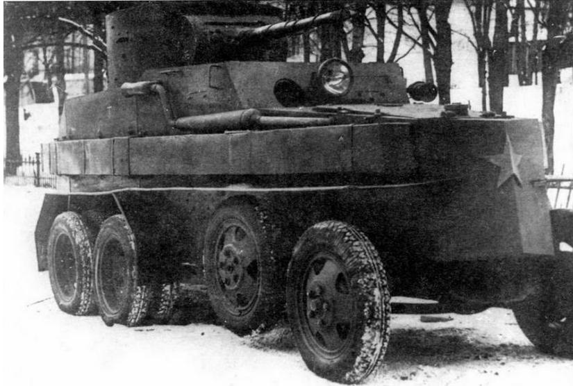
*Плавающий броневедомитель ПБ-4. Один из первых образцов, имевший понтоны, заполненные прессованной пробкой, вдоль всей длины корпуса*
