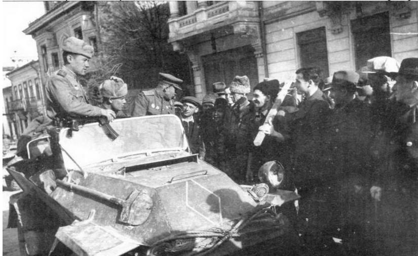
*Бронеавтомобиль БА-64, переделанный во фронтовых условиях в открытую командирскую машину на улице г.Батошаны. Румыния, 1944 год. Верхняя, по-видимому поврежденная, часть корпуса броневика срезана по стыку с нижними бронелистами. Ветровое стекло явно трофейного происхождения*
