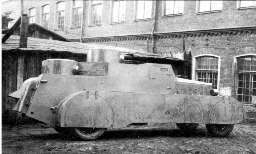
*Бронеавтомобиль БАД-1 на заводском дворе. Хорошо видны пулеметные башни, расположенные в два яруса. Обращает на себя внимание откидная бронировка колесных ниш*
