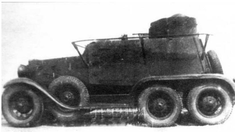
*Опытный образец броневедомобиля ГАЗ-ТК. 1934 год*
