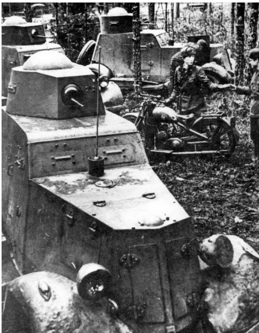
*Подразделение броневиков на исходных позициях. На переднем плане — БА-20, у которого поручневая антенна заменена на штыревую. 1942 год*
