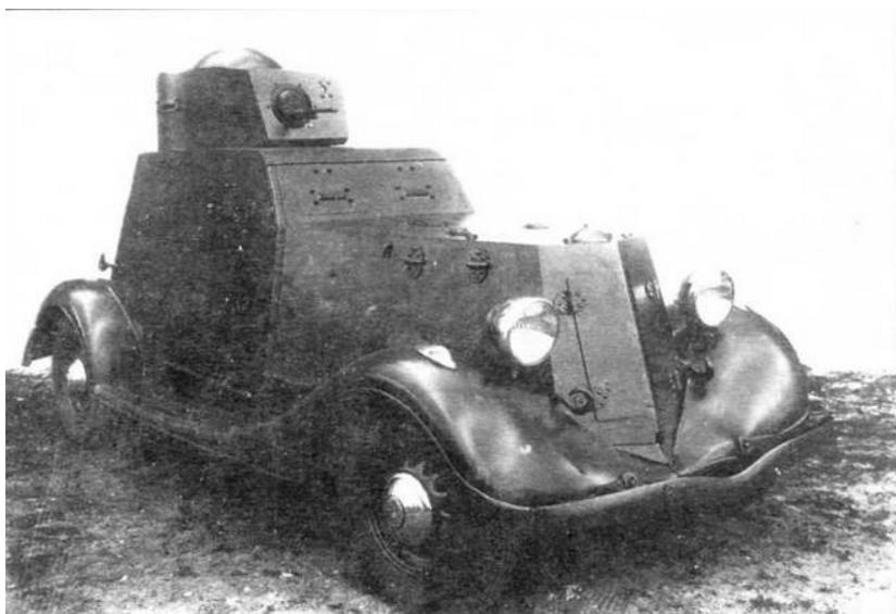
*Бронеавтомобиль БА-20—самый массовый и наиболее удачный отечественный легкий броневик предвоенного периода. На фото — линейный броневик без радиостанции*
