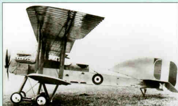
«Бомбер» отличался оригинальным четырехколесным шасси
