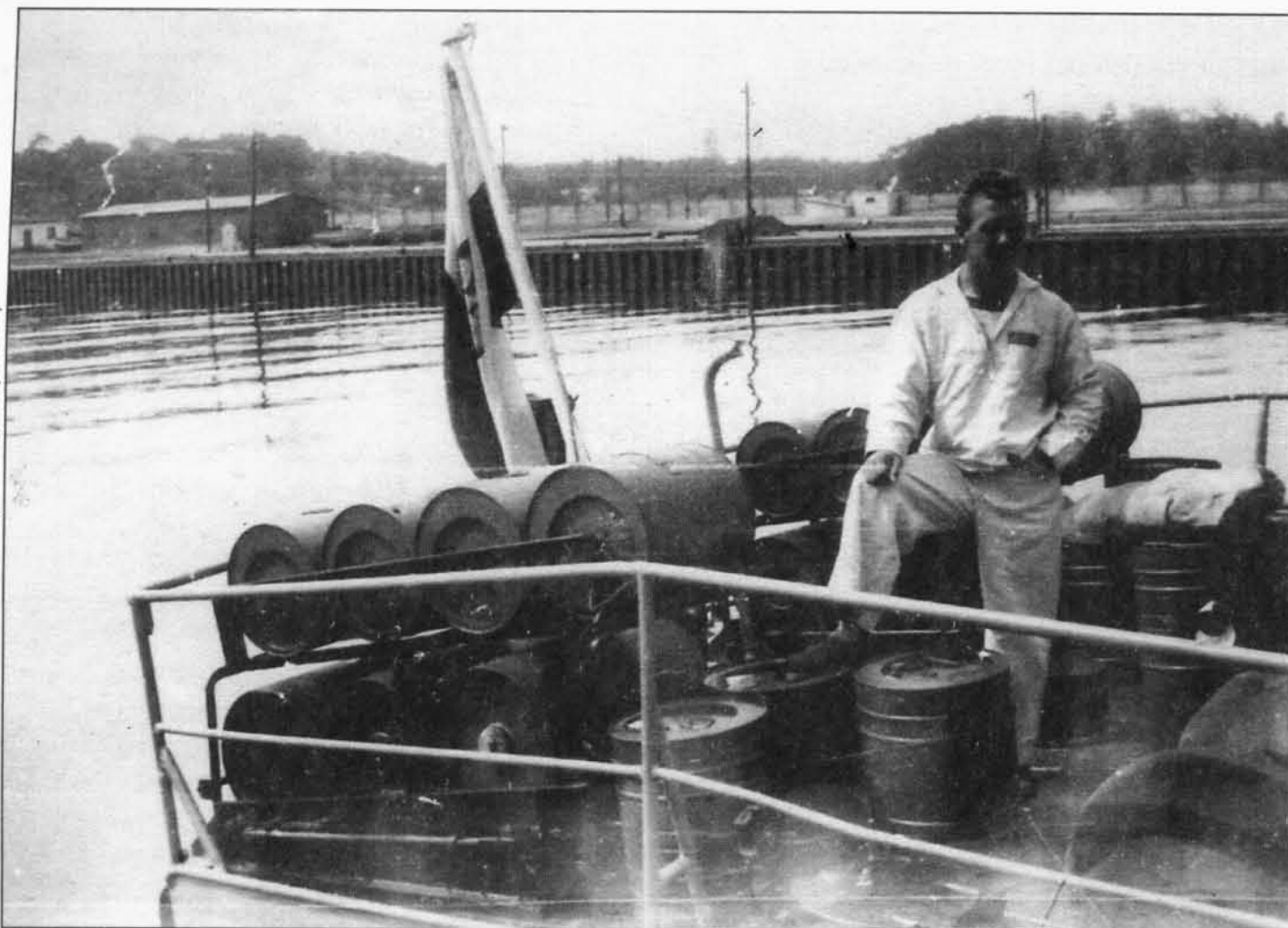
Глубинные бомбы Б-1 в кормовых бомбосбрасывателях на одном из противолодочных кораблей ВМФ Польши
