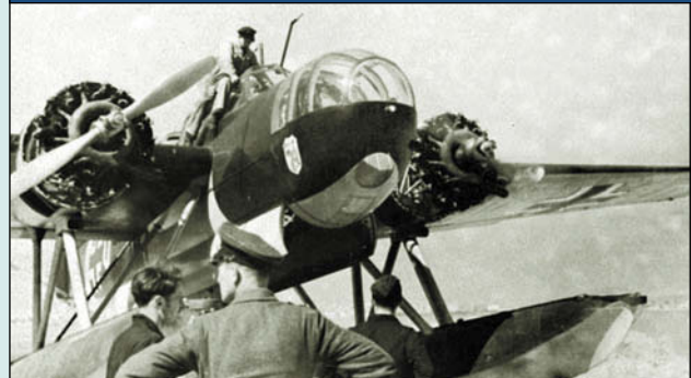
Техобслуживание гидросамолета Фоккер T.VIII-W одной из частей люфтваффе
