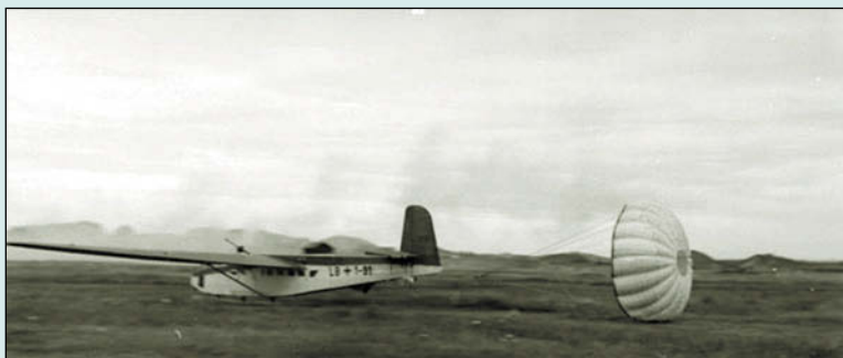
Вверху: DFS 230B комплектовался тормозным парашютом Внизу: планеры DFS 230 на аэродроме. На переднем плане – самолет-буксировщик Do 17E
