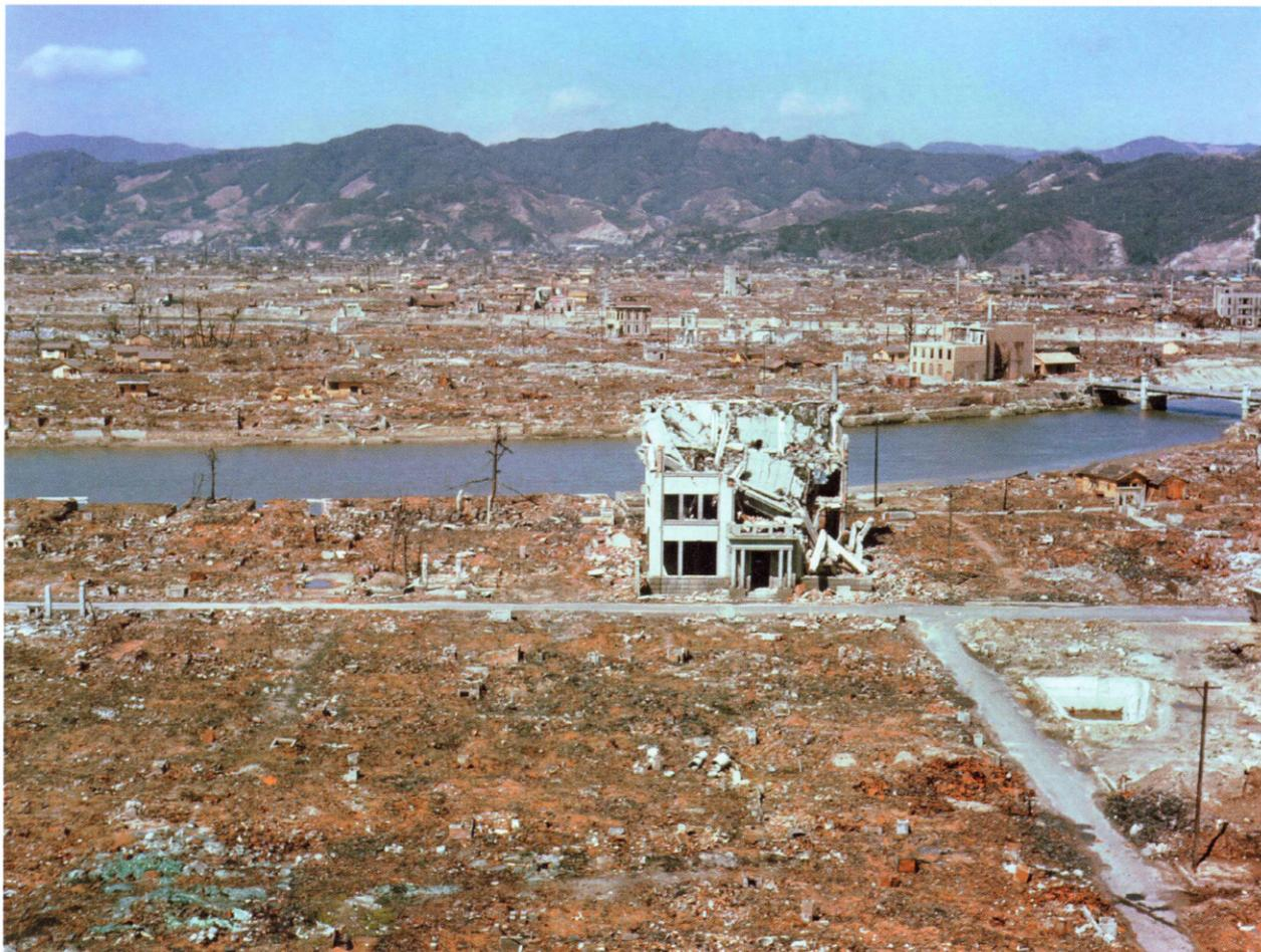
В Хиросиме более или менее устойчивыми оказались только сооружения из железобетона, но и они получили серьезные повреждения, особенно если были расположены ближе чем на две мили (3,2 км) от эпицентра («нулевой отметки»).
