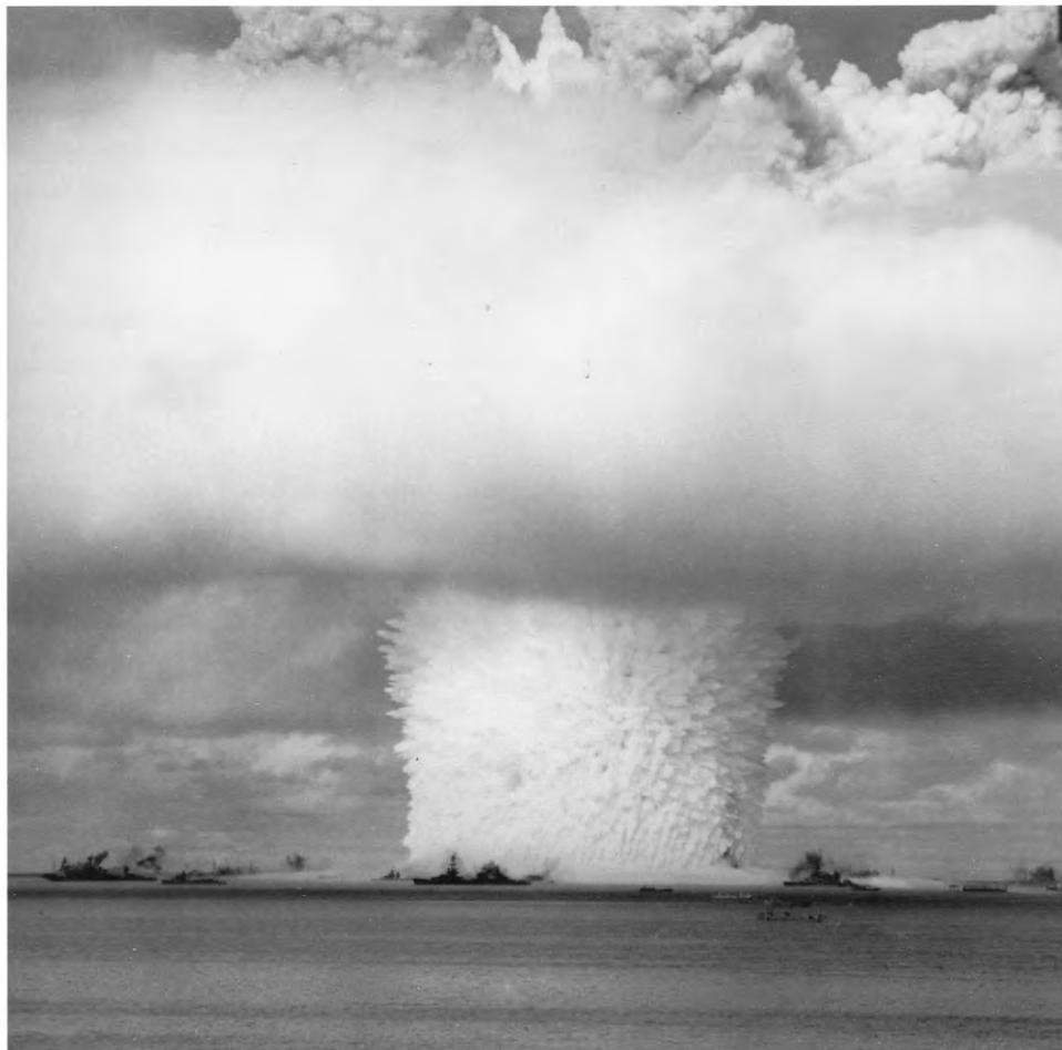
В столбе от взрыва «Бэйкер» было свыше миллиона тонн морской воды. Он поднимался вверх со скоростью 3300 м/с, диаметр был около 300 м. Опадая, столб обрушил воду и пар на корабли, не пострадавшие от прямого воздействия взрыва, и заразил их.
