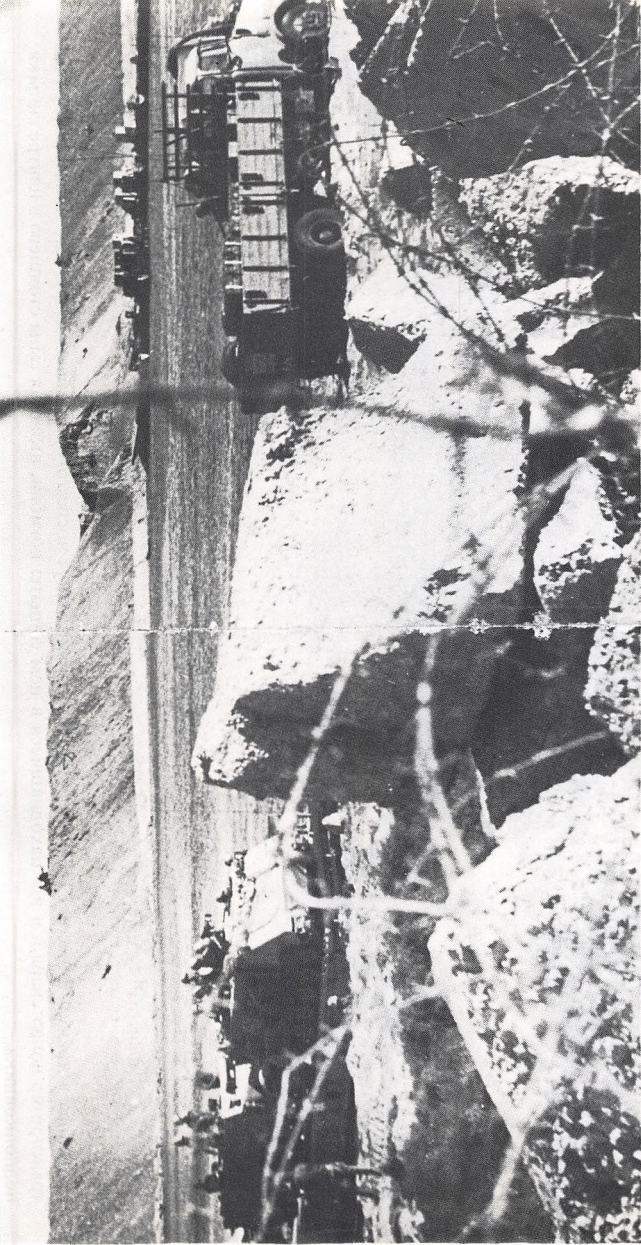
Восточный (израильский) берег Суэцкого канала. Отчетливо видно место, где египтяне с помощью водных пушек размывали песчаную насыпь, чтобы их войска смогли форсировать канал и взять линию Бар-Лева.
