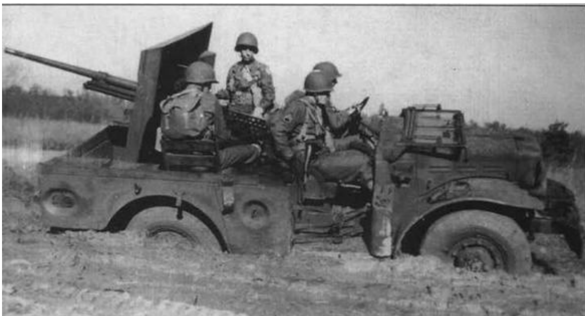
Истребитель танков М6— автомобиль "Додж" 3/4 с 37-мм пушкой в кузове
