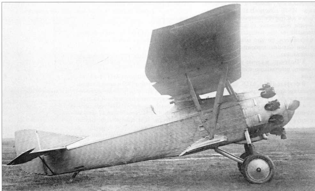
Опытный АНТ-5 с мотором Юпитер IV. Государственные испытания, октябрь 1927 г.
