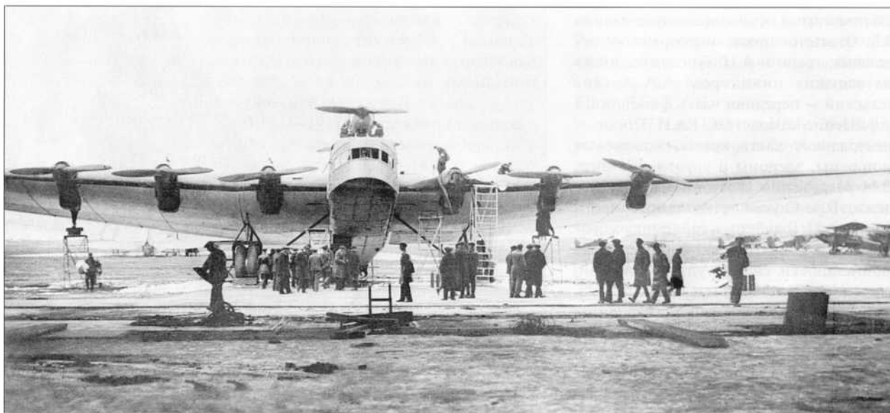
Сборка АНТ-20 на Центральном аэродроме
