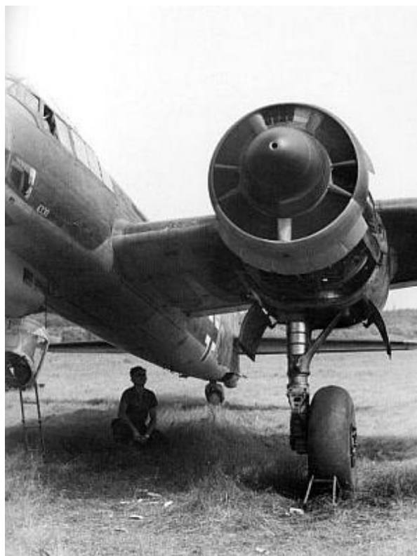
Замена двигателя, выработавшего свой ресурс, на Ju88A № 4330 из I/KG77. Лето 1941 г.
