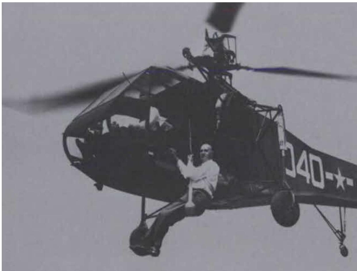
*Сикорский демонстрирует надежность спасательной лебедки вертолета «Sikorsky R-4»*
